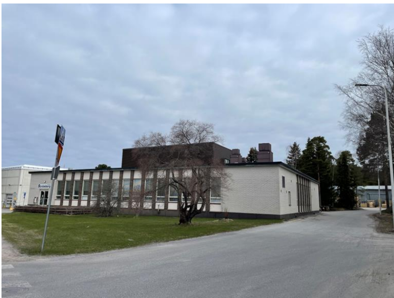
TSR, eteläsivu ja itäpäätyä.
