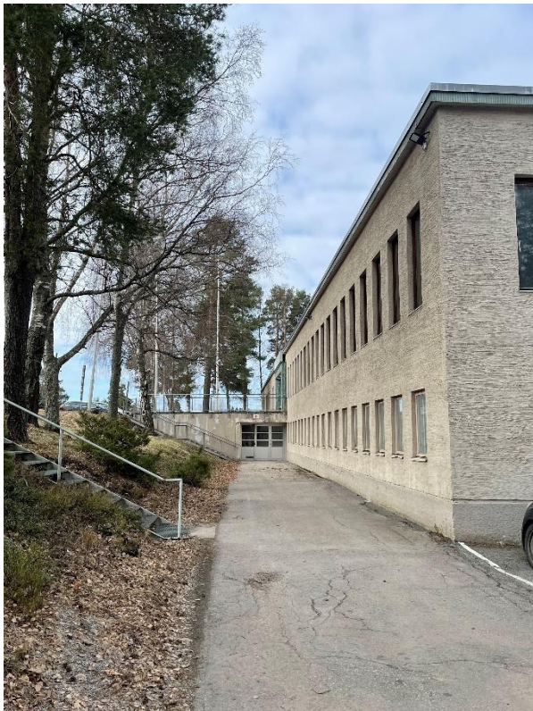
NN, julkisivu sisäpihan puolelta kuvattuna.
