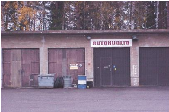
VA, osa lounaissivusta.
