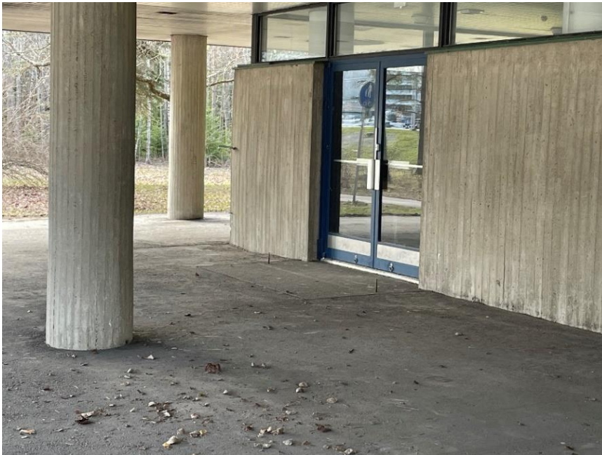
TST, koillispäädyn sisäänkäynti.
