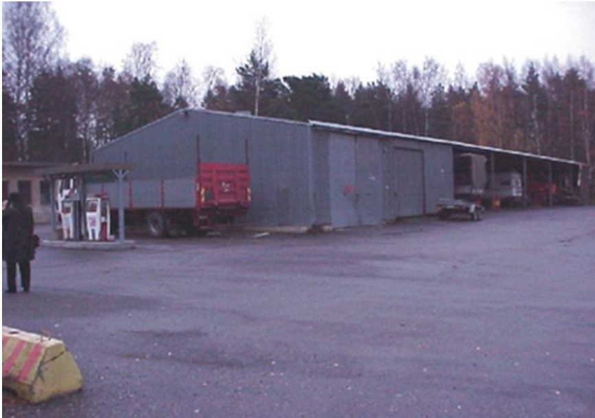
VP, katoksen länsipääty.
