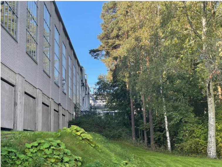
MM, pohjoispääty Sähkömäeltä kuvattuna.
