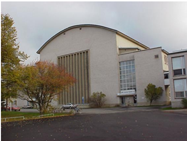
FF, korkeajännitelaboratoriahallin länsijulkisivu.
