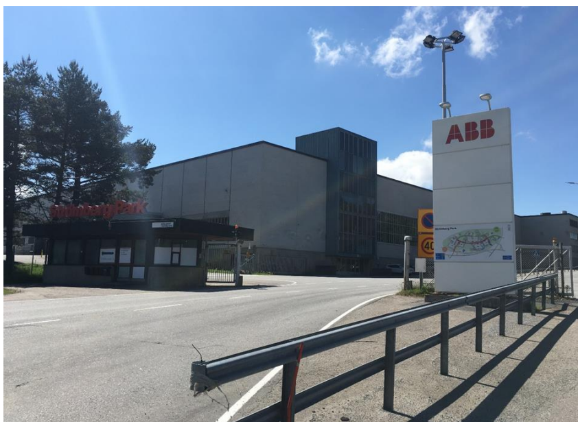
FF, itäisimmän laajennuksen pohjoisjulkisivun sisäänkäynti. Etualalla muuntajaportti.
