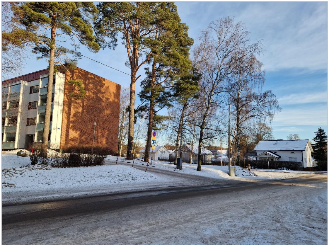
Suunnittelualueutta vastapäätä Karhuntien pohjoispuolella sijaitseva kerrostalorakennus. Kuva: Eija Kangas.
