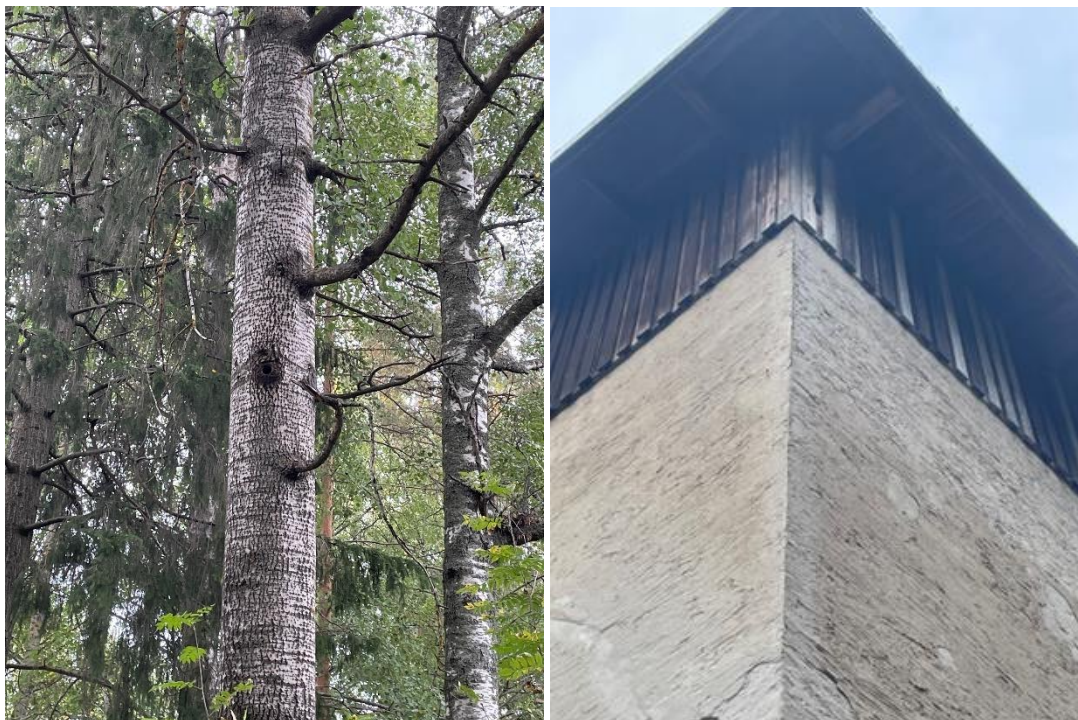
Liito-oravan mahdollisesti käyttämiä pesäpaikkoja; kolohaapa ja rakennuksen julkisivussa oleva kulkuaukko.
