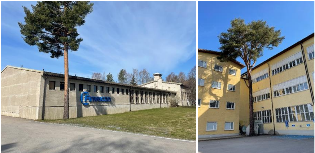
Maisemallisesti merkittäviä mäntyjä BB- ja VL-rakennuksen piha-alueilla.
