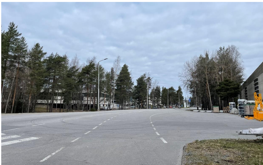
Strömbergin puistotie pohjoiseen päin kuvattuna. Oikealla puolella näkyy GG-rakennuksen lastausalue ja vasemmalla TST-rakennus.
