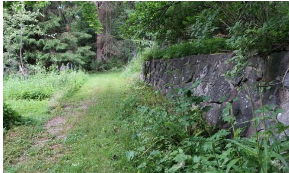
Kuva 23. Kivisiä pengerryksiä saunan ympäristössä.
