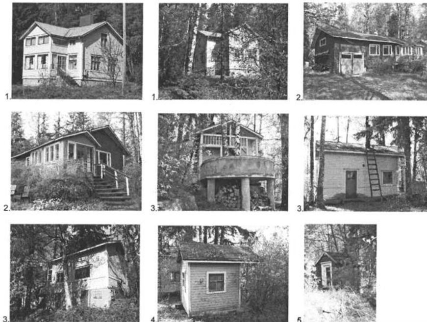
Kuva 14. Lomarakennusten pihapiirin rakennukset vuoden 2004 inventointikortista (Pohjanmaan museo).
