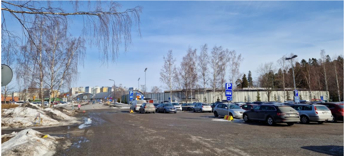
Katsomorakenteet etelän suunnalta
