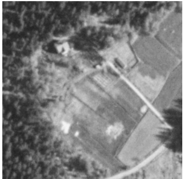
Pihapiiri vuoden 1955 ilmakuvasa (Historialliset ilmakuvat). Kuvassa näkyy aikaisempaan kuvaan rakennettuna kasvilava pihatien pohjoispuolelle, lato on purettu ja uuden mökin paikkaan on jo tehty pohjatöitä
