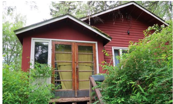
Verannan pääty koilliseen.
