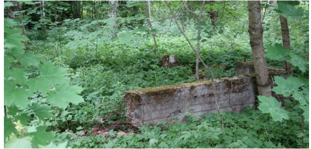
Vanhan kasvilavan perustukset pihan länsiosassa.
