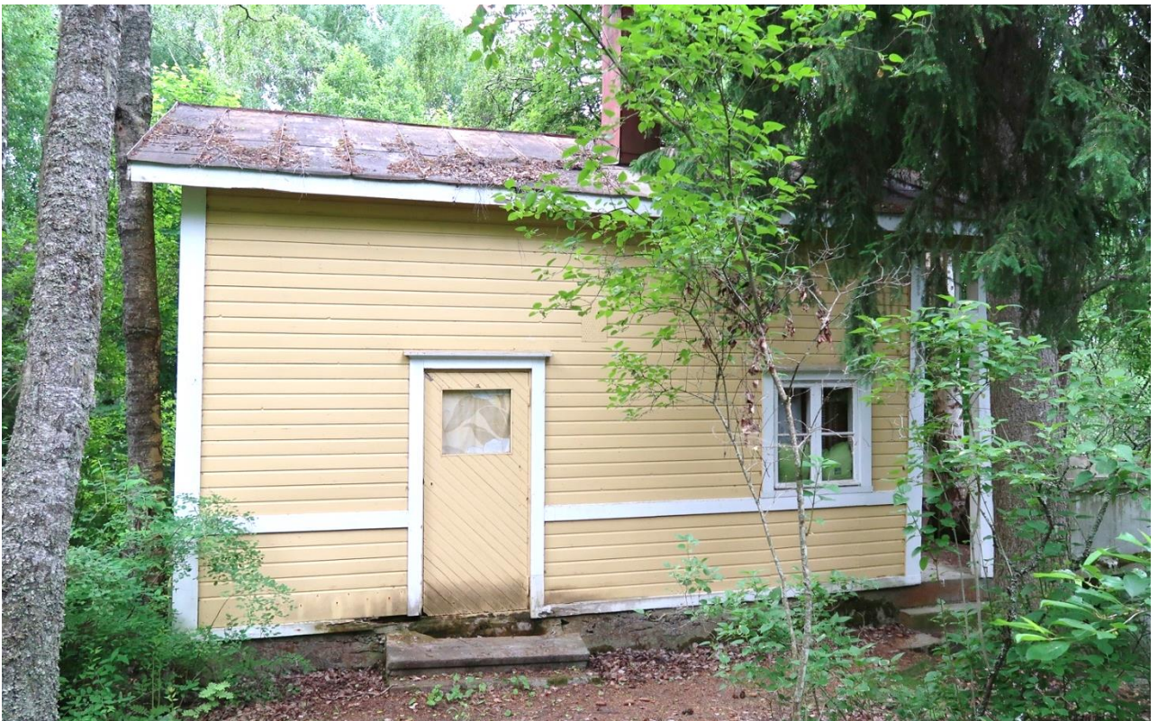
Saunan julkisivu pohjoisesta.
