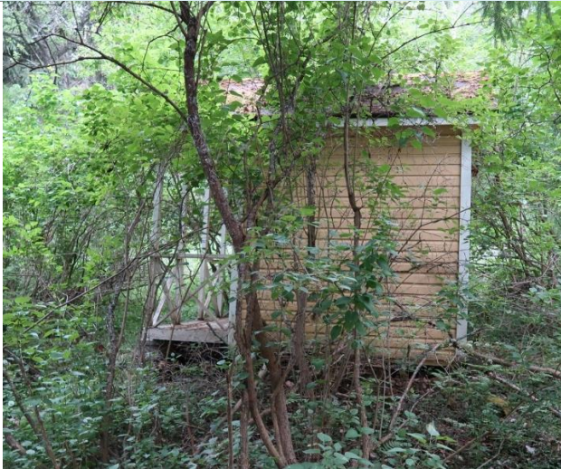
Julkisivua saunan suunnasta etelästä
