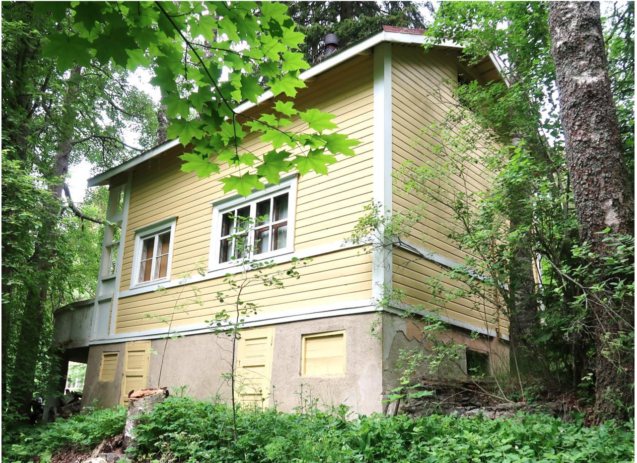
Sauna lännestä. Kellarikerroksessa on varastotilaa.
