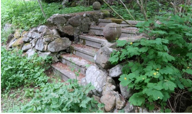
Saunan takana olevat kiviportaajat (betoni) ja pengerrystä pihan itäosassa.
