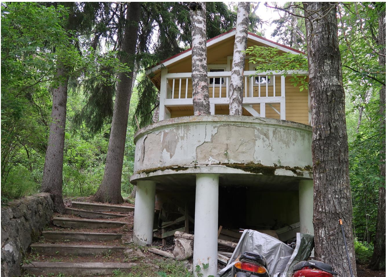
Sauna ja terassi lännen puolelta. Vasemmalla näkyy kivi/betonirakenteisia pengerryksiä ja kiviaitaa.
