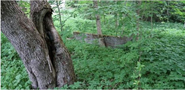
Vanhan kasvilavan perustukset pihan länsiosassa.
