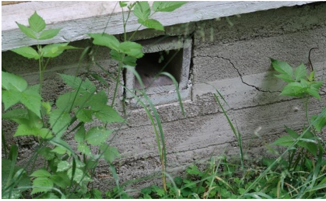
Tuuletusluukku vanhan osan kohdalla
