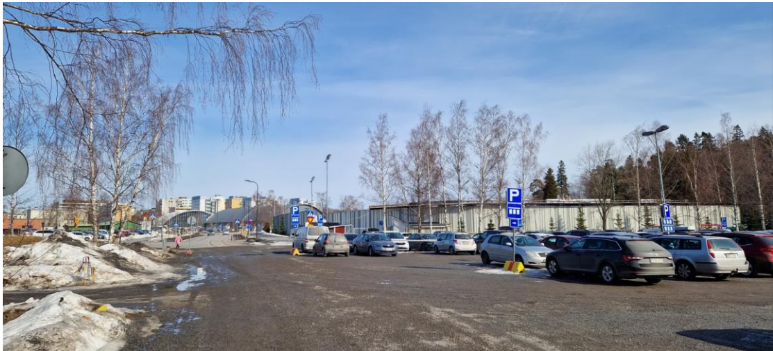
Läktarkonstruktionerna från söder
