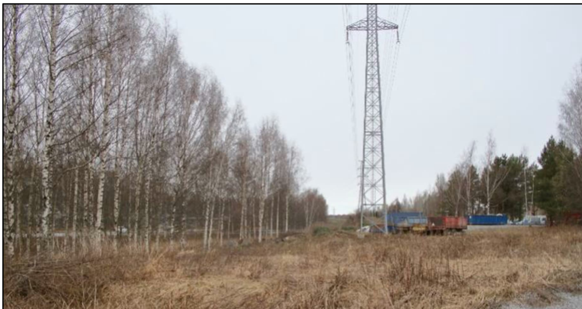
En stor elledning går parallellt med Förbindelsevägen genom området.
