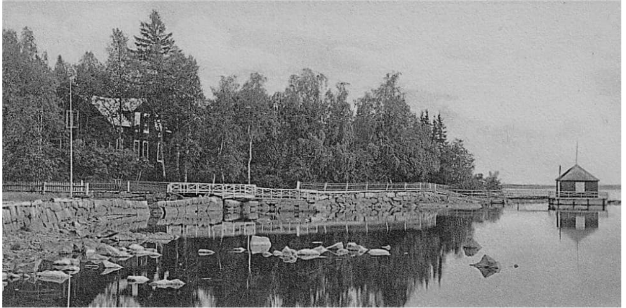
Suvilahden puolella sijainneen Rosenbergin huvilan ylellinen ranta-alue. Huvilarakennus tuhoutui 1900-luvun alkupuolella syttyneessä palossa (kuva Pohjanmaan museo).
