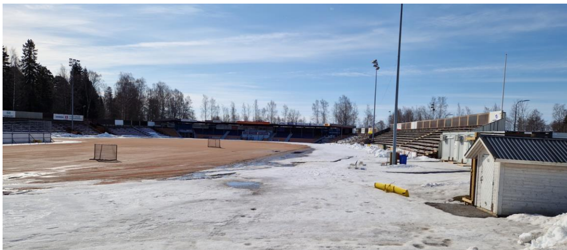
Läktarkonstruktionerna från norr
