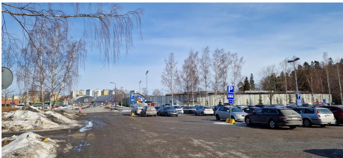
Läktarkonstruktionerna från söder
