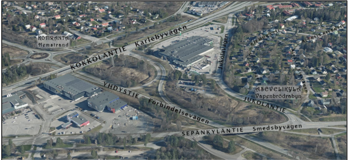
Flygbild av området mot nordost.
