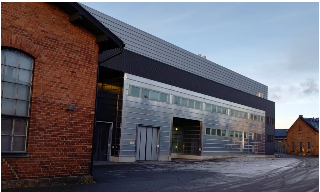
Monteringshallen har byggts ihop med och delvis kring den gamla smedjebyggnaden så att det har varit möjligt att bevara den skyddade byggnaden.
