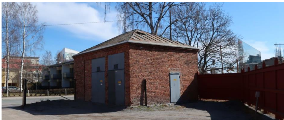
Transformatorbyggnaden fotograferad från Wärtsiläs tomt. Foto: Ramboll.
