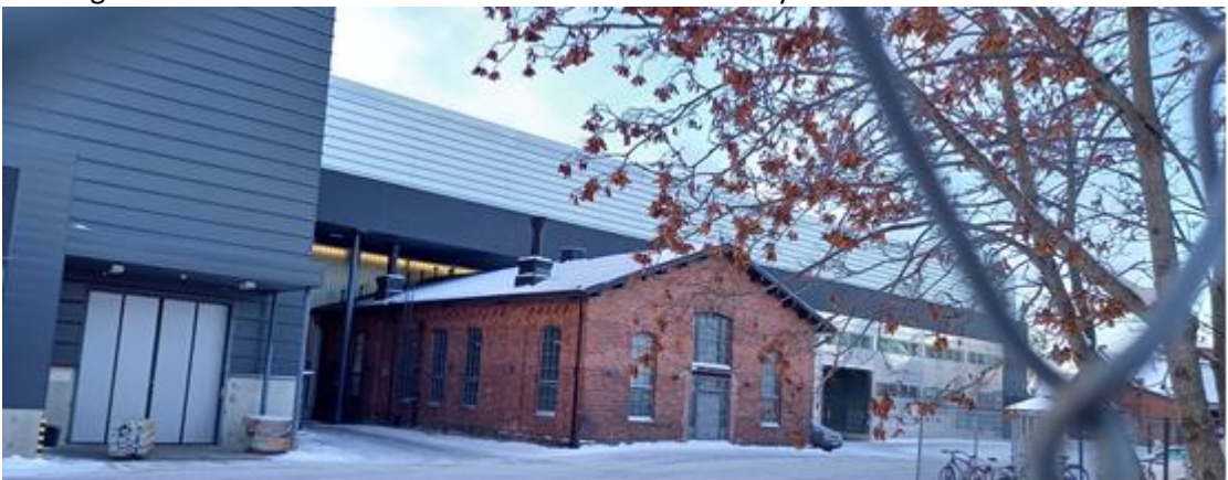
Rödtegelbyggnaden är smedjan, den grå byggnaden är monteringshallen.
