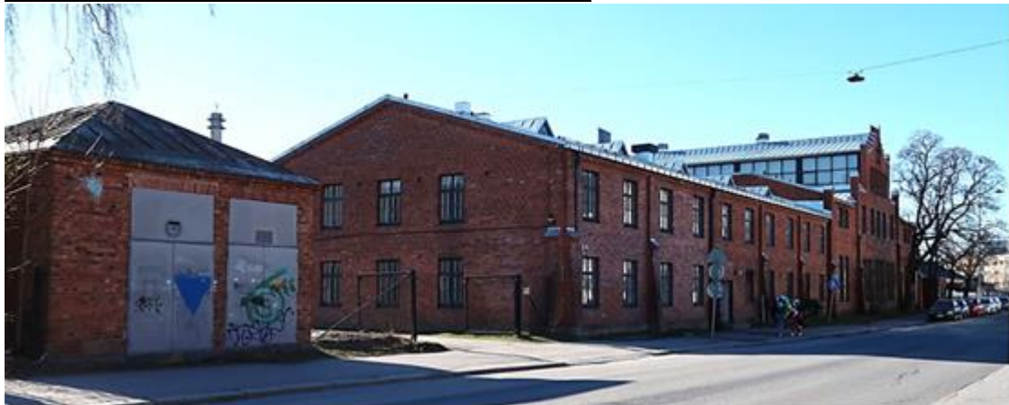
Vy från Storalånggatan. Transformatorbyggnaden i förgrunden till vänster, vevstaksfabriken till höger. Foto: Ramboll.
