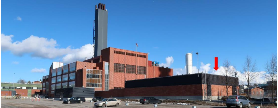
Diesellaboratoriet fotograferat från parkeringsplatsen i väster.
