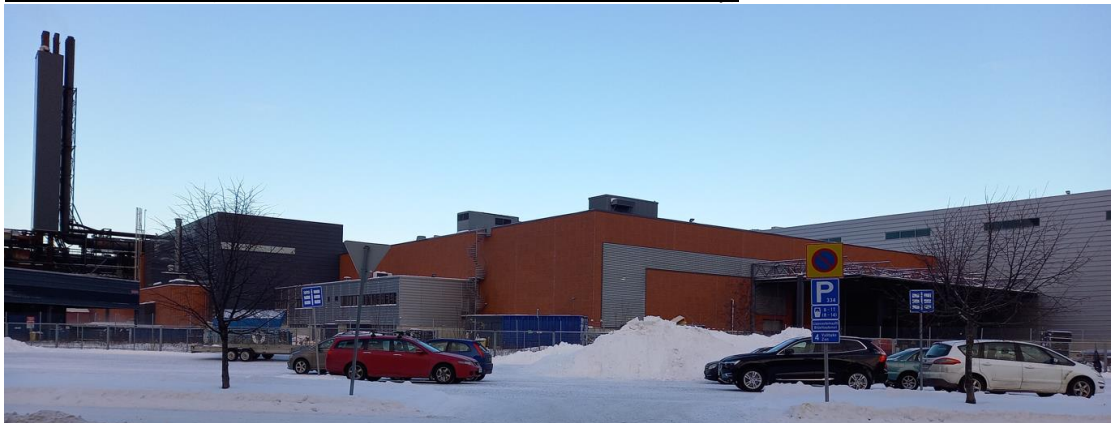
Tehdasrakennus kuvattuna Ratakadulta. Kuvassa vasemmalla näkyy Diesel-laboratorio ja luovutussolu. Keskellä oleva punatiilinen osa on W20-tehdas. Kuvan oikeassa laidassa näkyy kokoonpanohalli.
