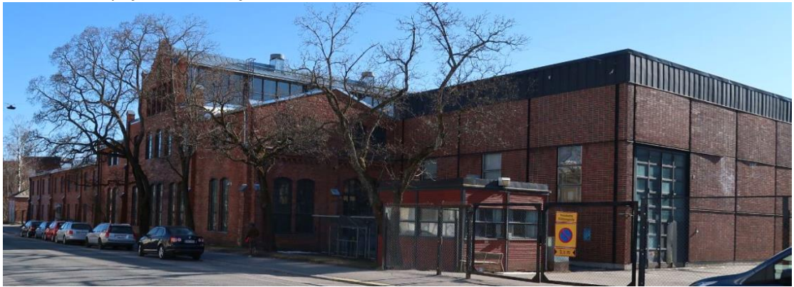
Kiertokankitehdas vuonna 2021. Kuva: Ramboll
