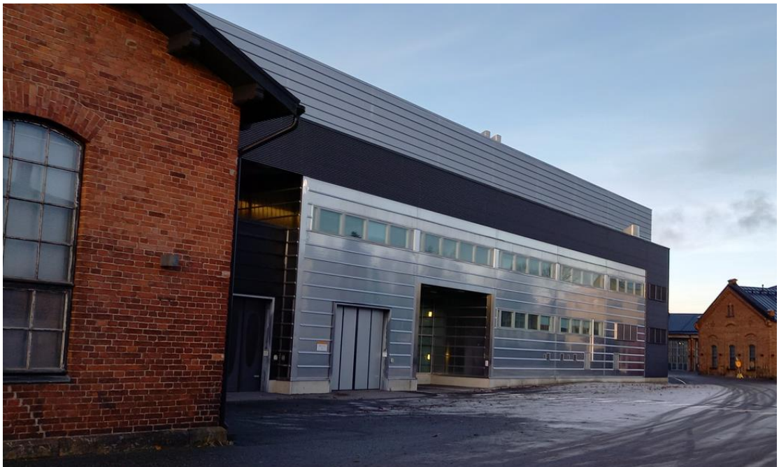
Kokoonpanohalli on rakennettu vanhaan takomorakennukseen kiinni ja osittain sen ympärille niin, että suojeltu rakennus on saatu säilytettyä.
