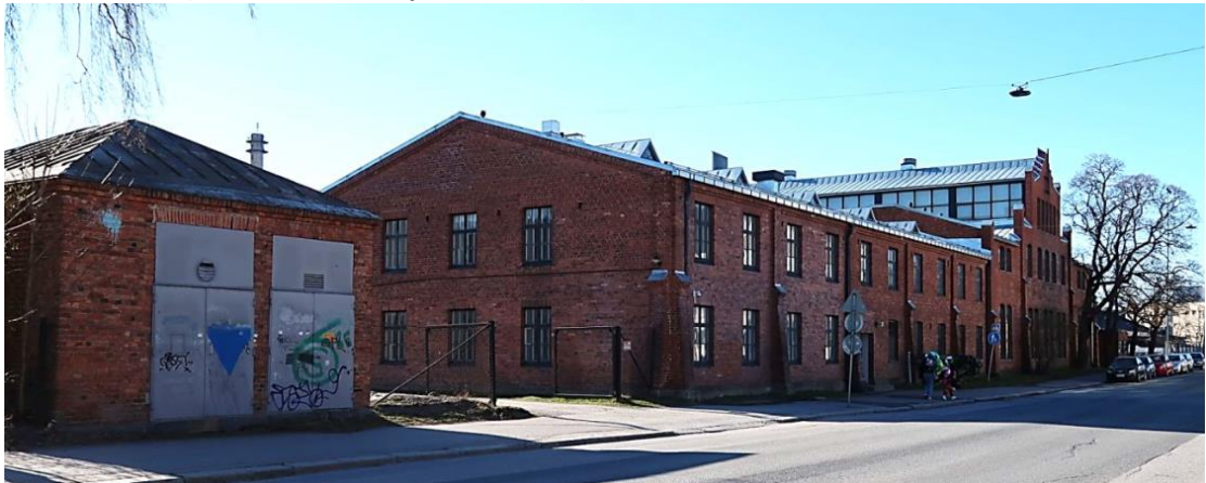
Näkymä Pitkäkadulta. Vasemmalla etualalla muuntamo, oikealla Kiertokankitehdas. Kuva. Ramboll.
