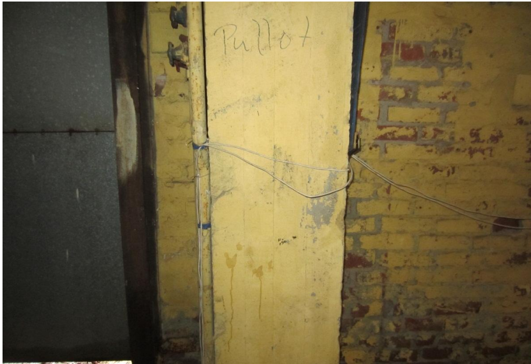
Kuva 9. Mittauspiste MX3. Kannettavalla röntgenfluoresenssispektrometrillä saatujen tulosten perusteella pilarin pinnassa ei ole merkittävästi kohonneita pitoisuuksia raskasmetalleja. Mittauskorkeus noin 1500 mm lattiatason yläpuolella.
