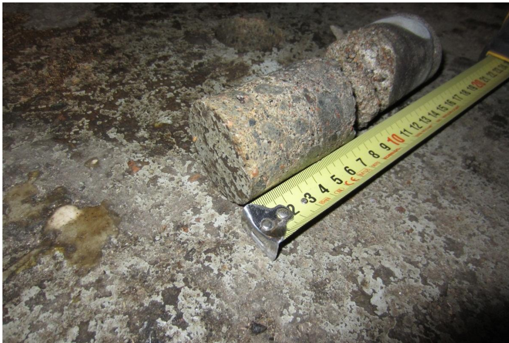
Kuva 18. Näyte PR7. Alapohja. Näyte ~70 mm pinnasta (harmaa maali + betoni ~70 mm), näyte katkaistu. Alapohjarakenne näytteenottokohdassa ylhäältäpäin lueteltuna on harmaa maali + betoni ~200 mm + sora. Näyte sisältää öljyhiilivetyjä C 10 -C 40 2500 mg/kg.
