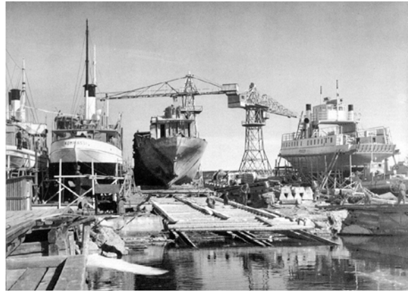
↑ Rauta-aluksia Onkilahden konepajan telakalla Mansikkasaassa, oletettavasti saaren luoteisosan kookkaalta laituriilta kuvattuna 1900-luvun alkupuolella. Laivat laskettiin mereen laiturin vierellä kulkevia kiskoja pitkin. Ajoittamaton kuva on yksityiskokolemasta. Ari Isotalon kotiarkisto. PM.
