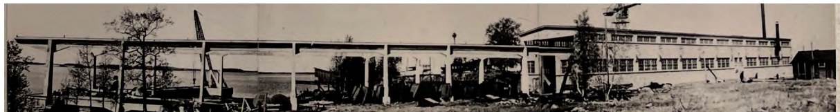
↑ Wärtsilä-Yhtymä Oy:n telakkahalli kuvattuna arviolta 1940-luvulla, ennen laajennusosia. VMM.
