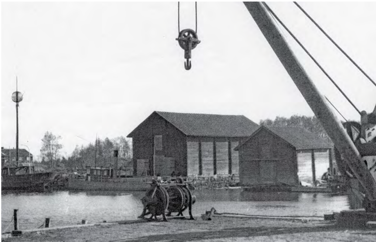
↑↑ Mansikkasaaren makasiini kuvattuna vastarannalta Merimuseon päärakennukselta. Makasiinin julkisivut ovat säilyneet hyvin alkuperäisessä asussaan. Makasiini on perustettu vedenalaisen hirsiaarkun ja louhetäytön päälle.
