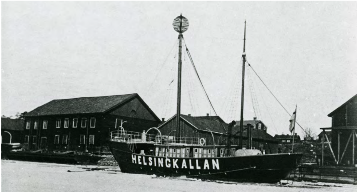
↑ Majakkalaiva Helsingkallanin (1885) perän takana kuvassa vasemmalla näkyy vuonna 1803 rakennettu kaksikerroksinen tulli- ja pakkahuone. Valokuvaaja tuntematon. VMM.
