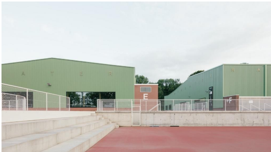
Bild 51 Love pt. II Sports Facilities (Charleroi, Belgia) återger den estetik som är bekant från industribyggnader. Planering Label Architecture, bild Stijn Bollaert
