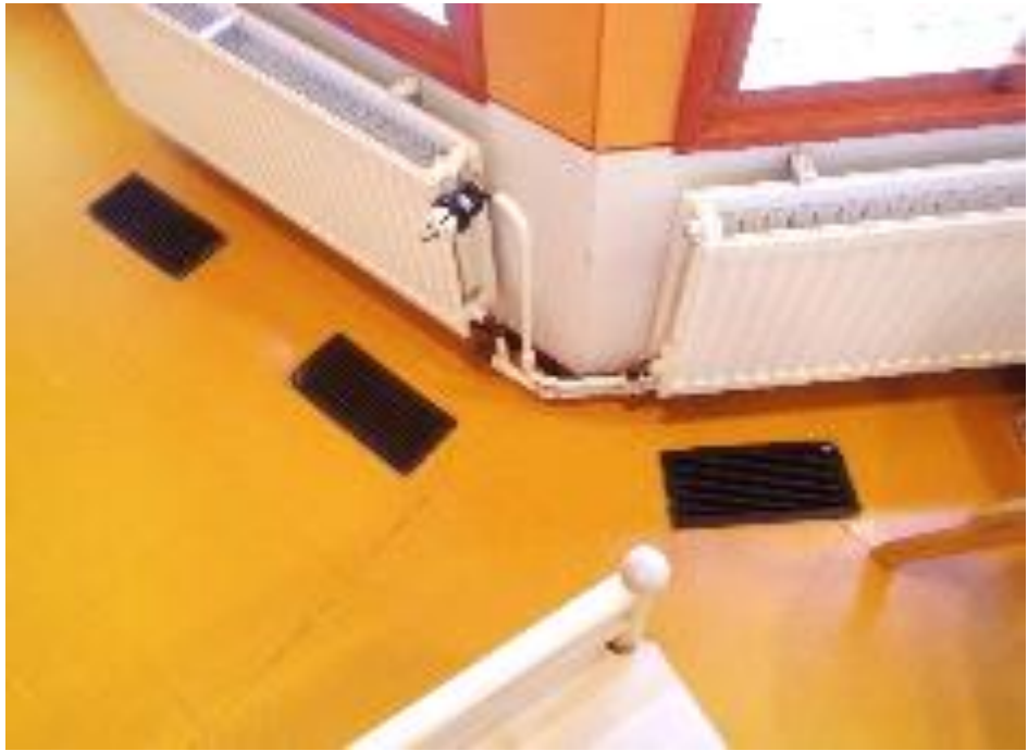
Kuva 28. Lattiassa olevia ilmakanavia (Lähde: Vahanen Rakennusfysiikka Oy 2018)
