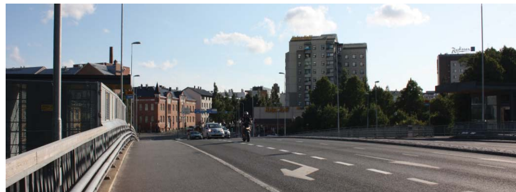
Kuva 5. Vaasan korkeimmat rakennukset sijaitsevat liikekeskustan alueella, maasillan kupeessa. Rakennukset ovat 10-kerroksiset.
