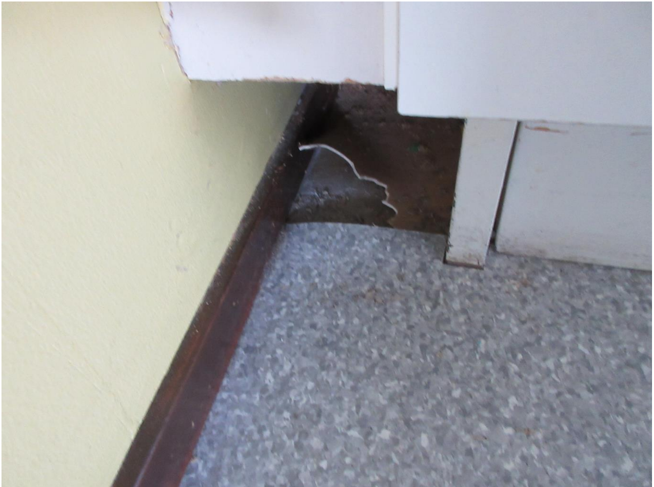
Kuva 11 17.9.2024 Ryhmähuone 204 2 krs: Näyte 11 otettiin vanhasta lattiamatosta, liimasta ja tasoitteesta, näyte ei sisällä asbestia
