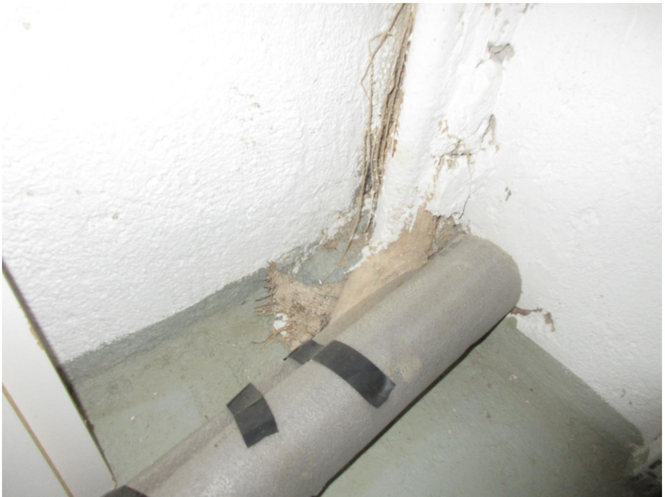
Kuva 5 17.9.2024 Varasto115 1 krs: Näyte 5 otettiin vanhan vesiputken massaeristeestä, näyte sisältää asbestia
