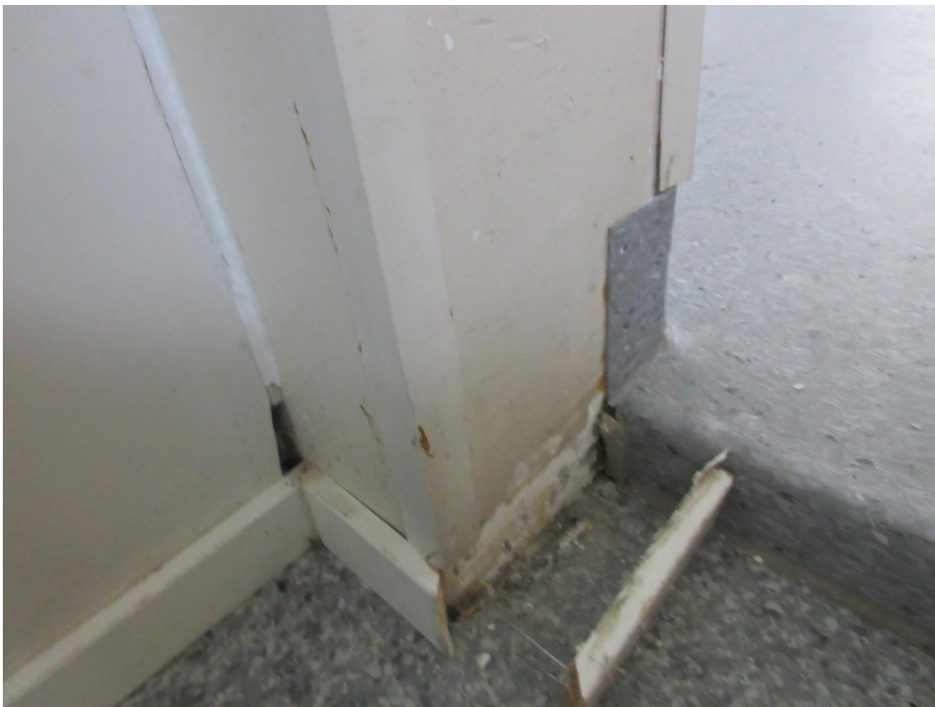
Kuva 1 17.9.2024 Vaatehuone 108 1 krs: Näyte 1 otettiin lattiamatosta, liimasta ja tasoitteesta, näyte ei sisällä asbestia
