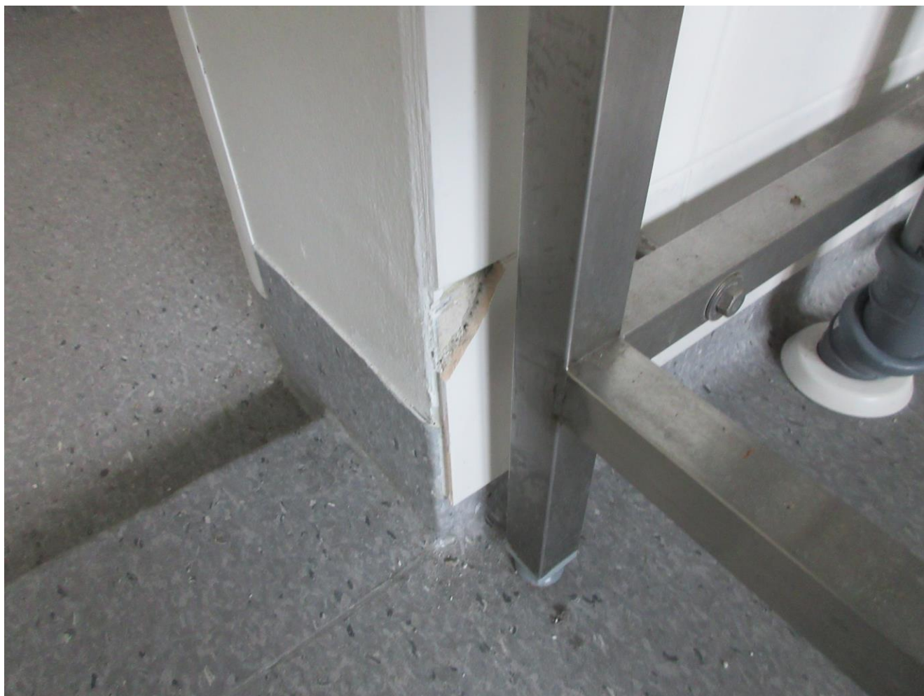
Kuva 3 17.9.2024 Keittiö111 1 krs: Näyte 3 otettiin seinäkaakelin sauma ja kiinnityslaasteista,näyte ei sisällä asbestia
