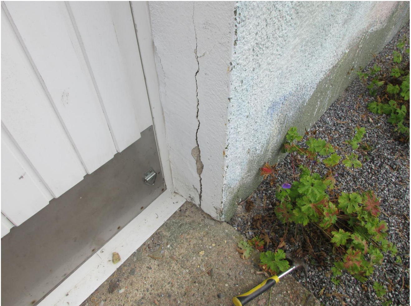
Kuva 13 17.9.2024 Sokkeli: Näyte 13 otettiin sokkelimaalista ja rappilaastista,näyte ei sisällä asbestia
