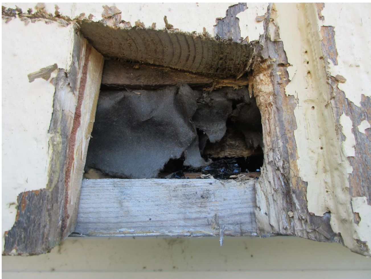
Kuva 16 26.9.2024 Julkisivu luoteeseen: Näyte 1 otettiin paneelin alaosan takana olevasta tervapaperista ja bitumieristeestä, tervapaperi ja bitumi eivät sisällä asbestia mutta tervapaperin PAH pitoisuus 8700 mg/kg ylittää vaarallisen jätteen rajaarvon
