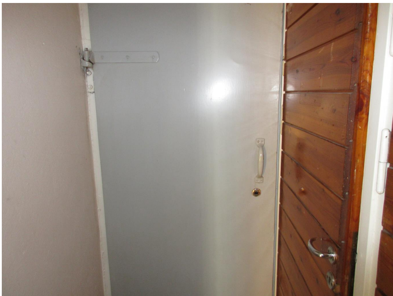
Kuva 4 17.9.2024 Kattilahuone 116 1 krs: Näyte 4 otettiin oven eristepahvista, näyte sisältää asbestia
