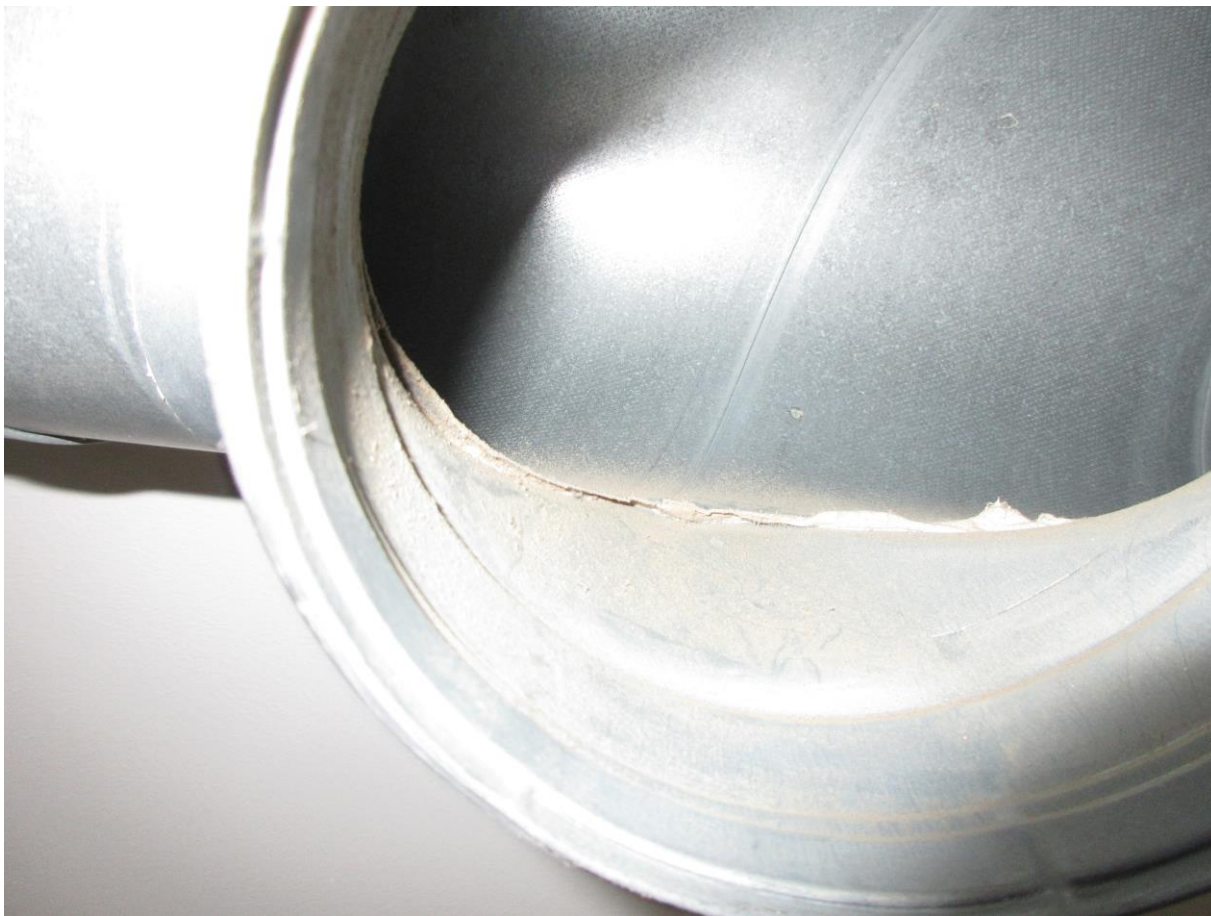
Kuva 9 17.9 2024 Kuraeteinen 201 2 krs: Näyte 9 otettiin iv kanavan tiivistyskitistä,näyte ei sisällä asbestia
