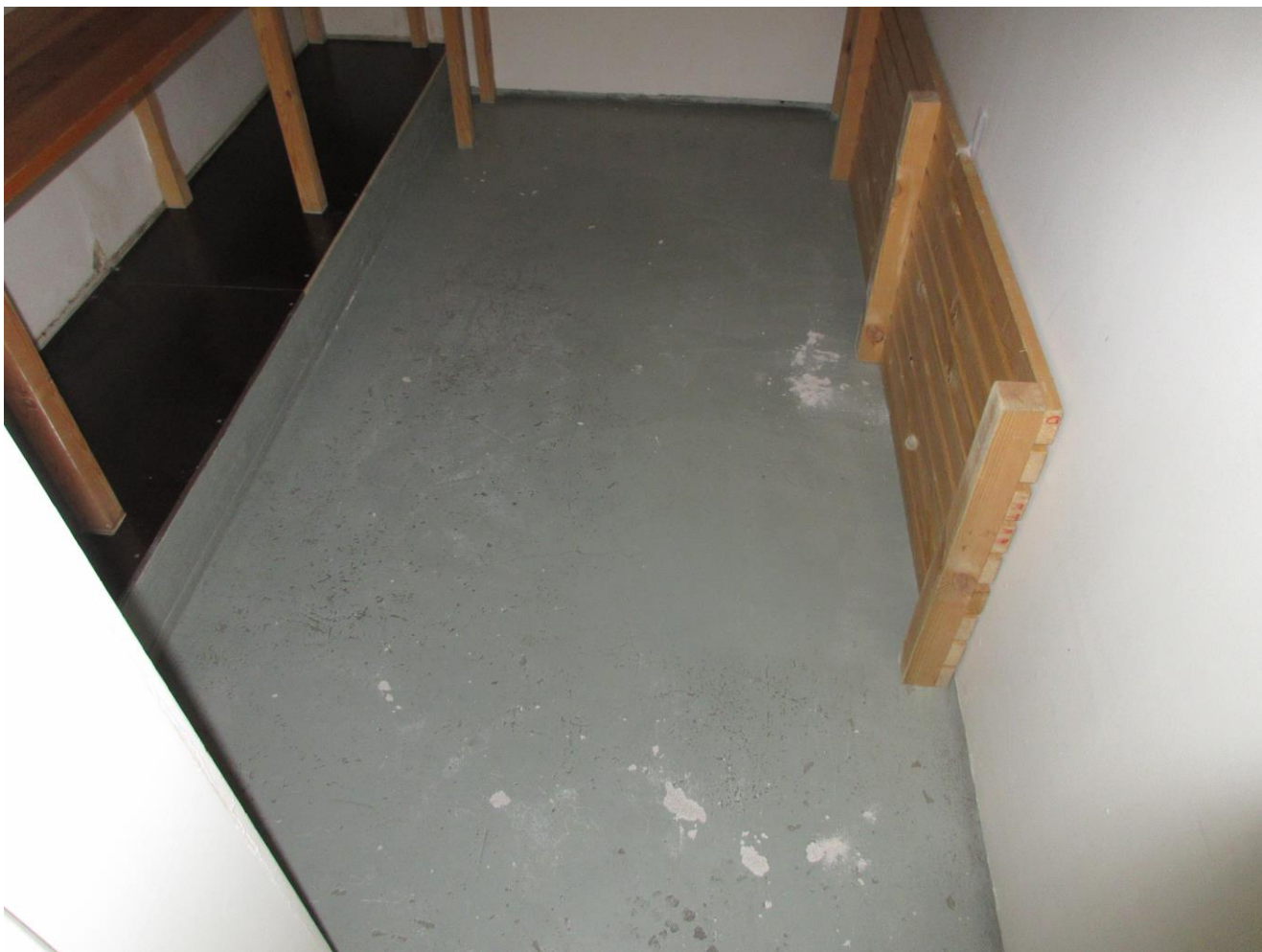
Kuva 6 17.9.2024 Kuivavarasto113,kylmiö 114 1 krs. Näyte 6 otettiin lattiamaalista,näyte sisältää lyijyä 160 mg/kg ja PCB <35 mg/kg .Maalijätteet luokitellaan tavanomaiseksi jätteeksi.
