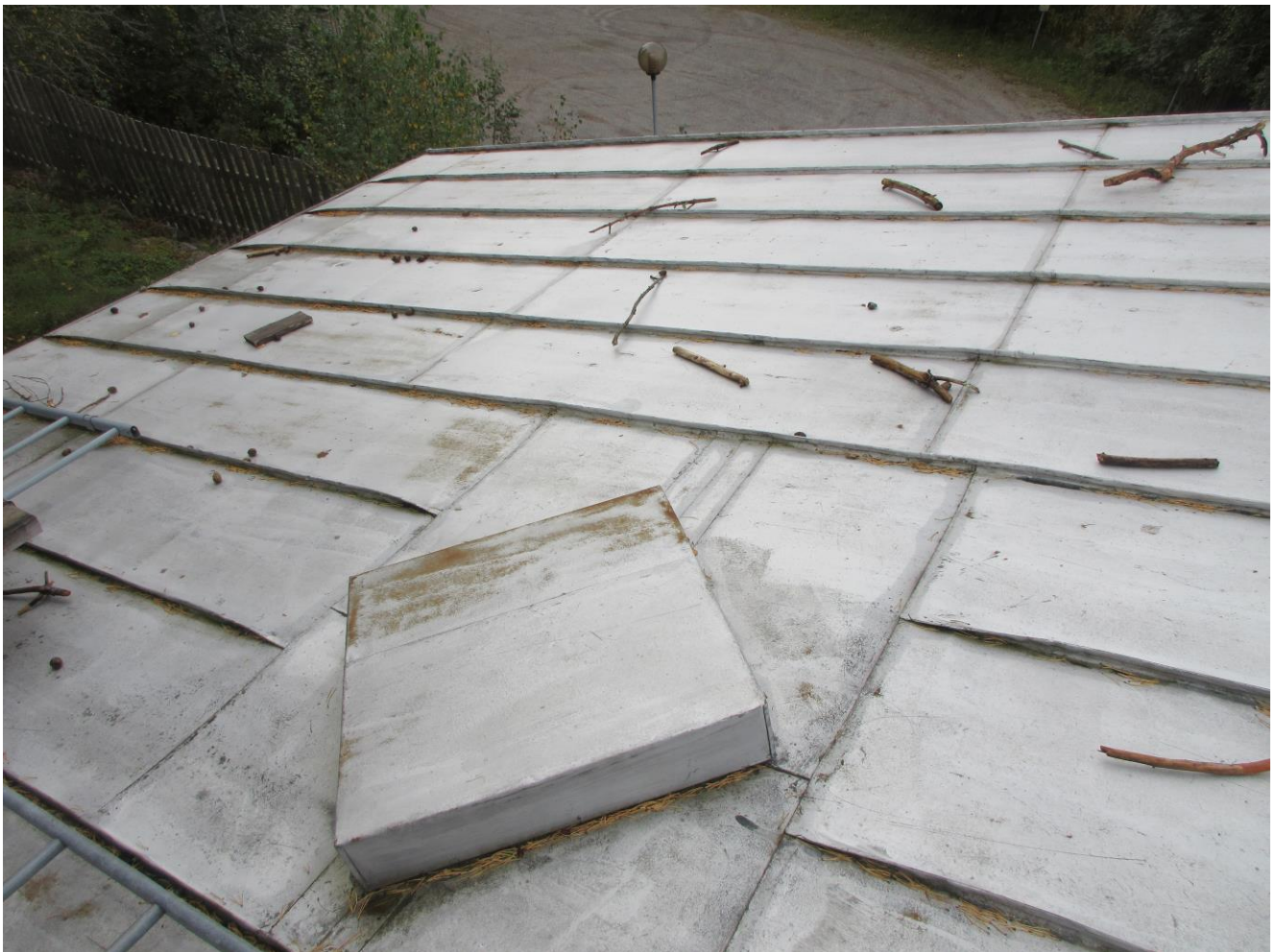
Kuva 15 17.9.2024 Vesikatto: Näyte 15 otettiin vesikaton peltimaalista, näytteen Raskasmetallipitoisuus ylittää rajaarvon lyijyn ja sinkin osilta, jätteet luokitellaan vaaralliseksi jätteeksi
