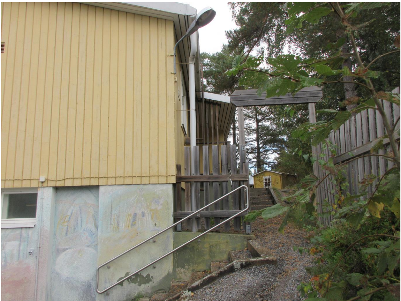
Kuva 14 17.9.2024 Julkisivut: Näyte 14 otettiin seinäpaneelin keltaisesta julkisivumaalista, näyte sisältää Raskasmetalleja yli rajaarvon lyijy ja sinkkiyhdisteiden osilta ja jätteet luokitellaan vaaralliseksi jätteeksi.
