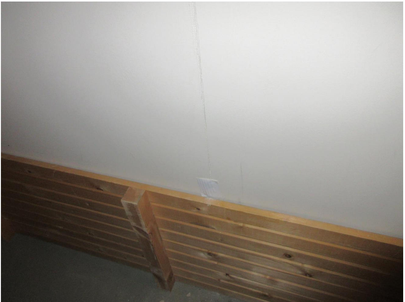
Kuva 7 17.9.2024 Kylmiö 114 1 krs: Näyte 7 otettiin Luja seinälevystä,näyte ei sisällä asbestia
