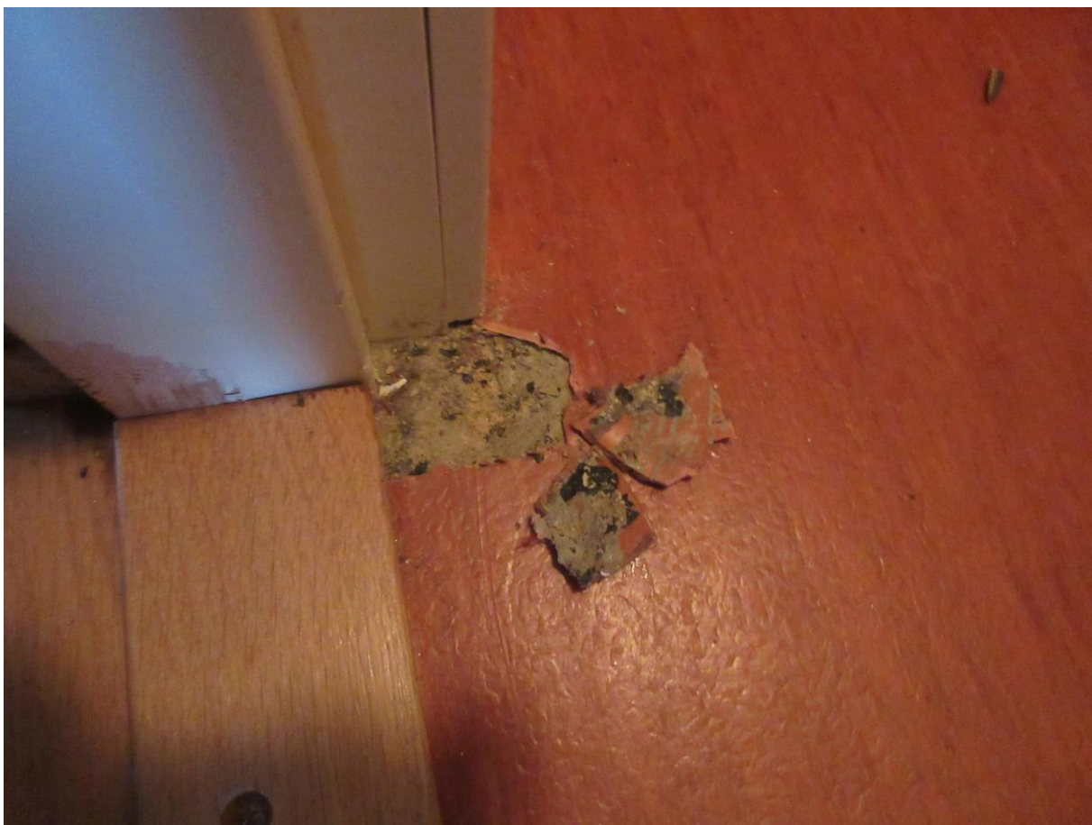
Kuva 10 17.9 2024 Välinevarasto 205 2 krs: Näyte 10 otettiin lattiamatosta, liimasta ja tasoitteesta sekä tasoitteen alla olevasta bitumiliimasta, näyte sisältää asbestia.
