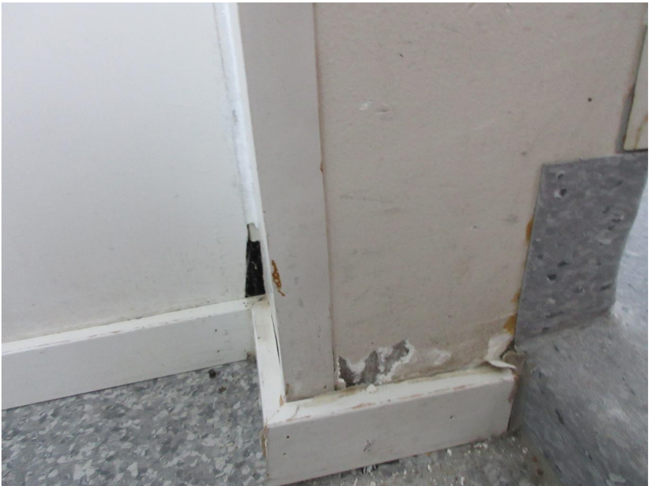
Kuva 2 17.9.2024 Vaatehuone 108 1 krs: Näyte 2 otettiin seinämaalista ja tasoitteesta, näyte ei sisällä asbestia
