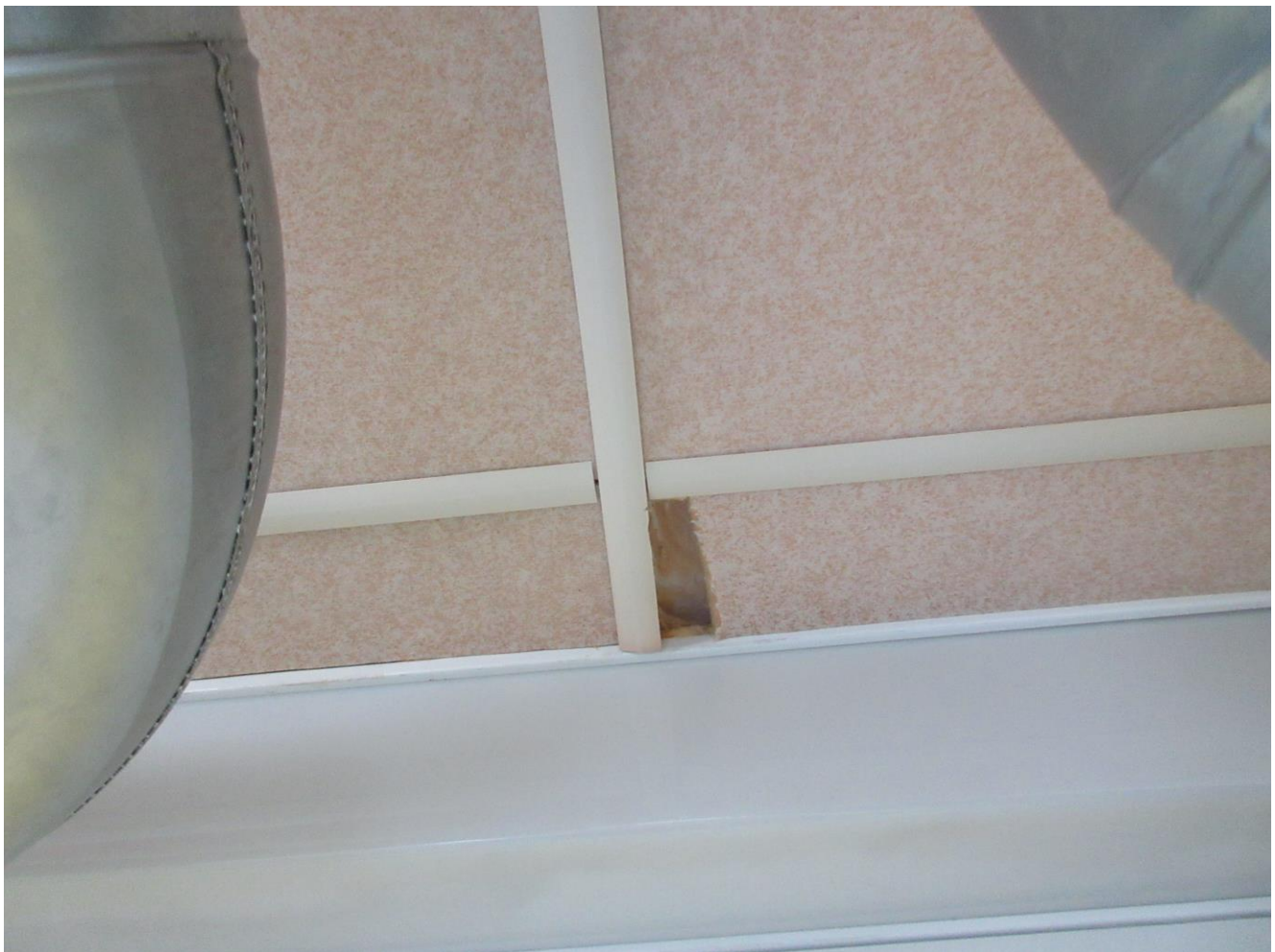
Kuva 12 17.9.2024 Ryhmähuone 204 2 krs:Näyte 12 otettiin alakaton akustiikkalevystä ja liimasta,näyte ei sisällä asbestia
