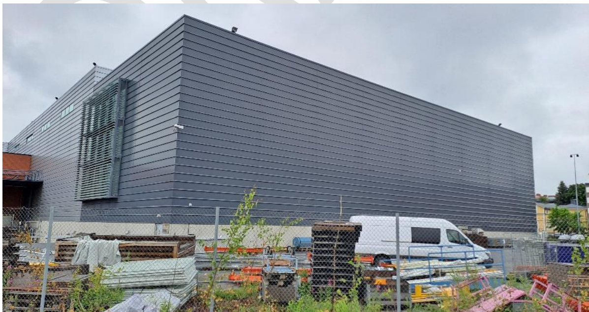
Kuva 8. Kokoonpanohallin eteläosa (Ramboll/Parviainen, 1.7.2024)
