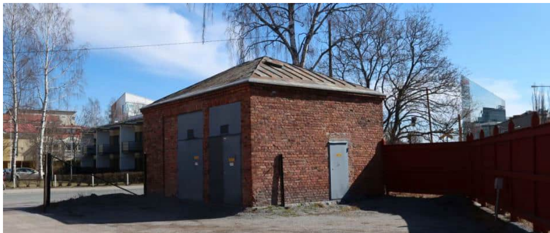
Muuntamo kuvattuna Wärtsilän tontin suunnasta. Kuva: Ramboll.
