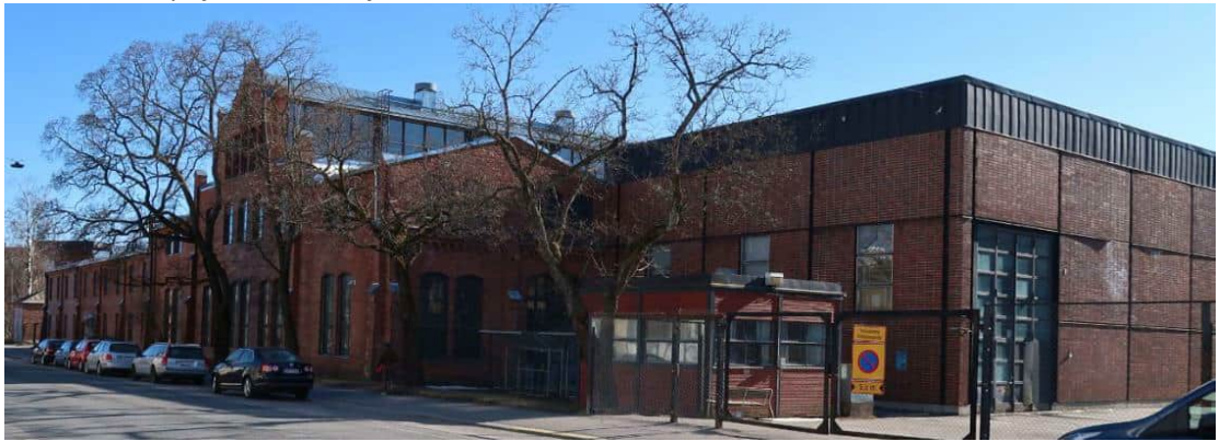
Kiertokankitehdas vuonna 2021. Kuva: Ramboll
