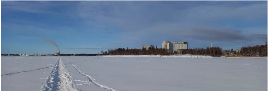
Maamerkit korostuvat tasaisessa suurmaisemassa. Kuvassa näkyviä maamerkkejä ovat sairaala-alue ja Vaskiluodon voimalaitos.
