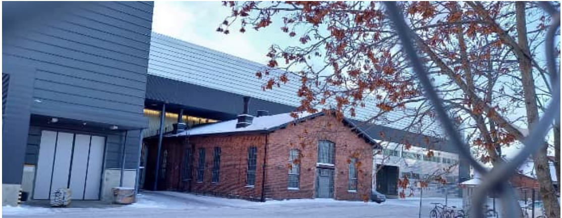
Punatiilinen rakennus on takomo, harmaa rakennus kokoonpanohalli
