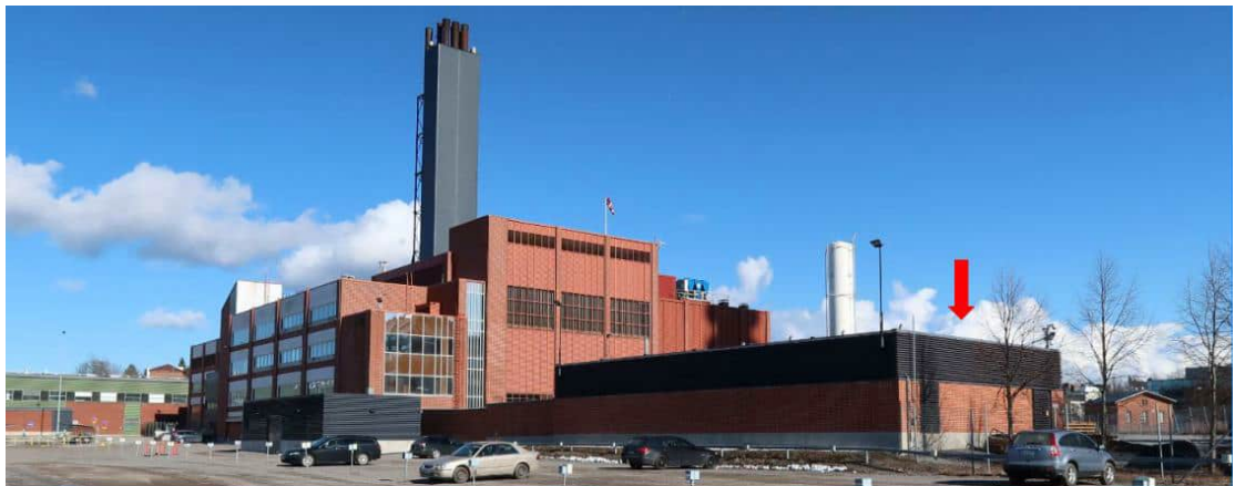
Diesellaboratoriet fotograferat från parkeringsplatsen i väster.
