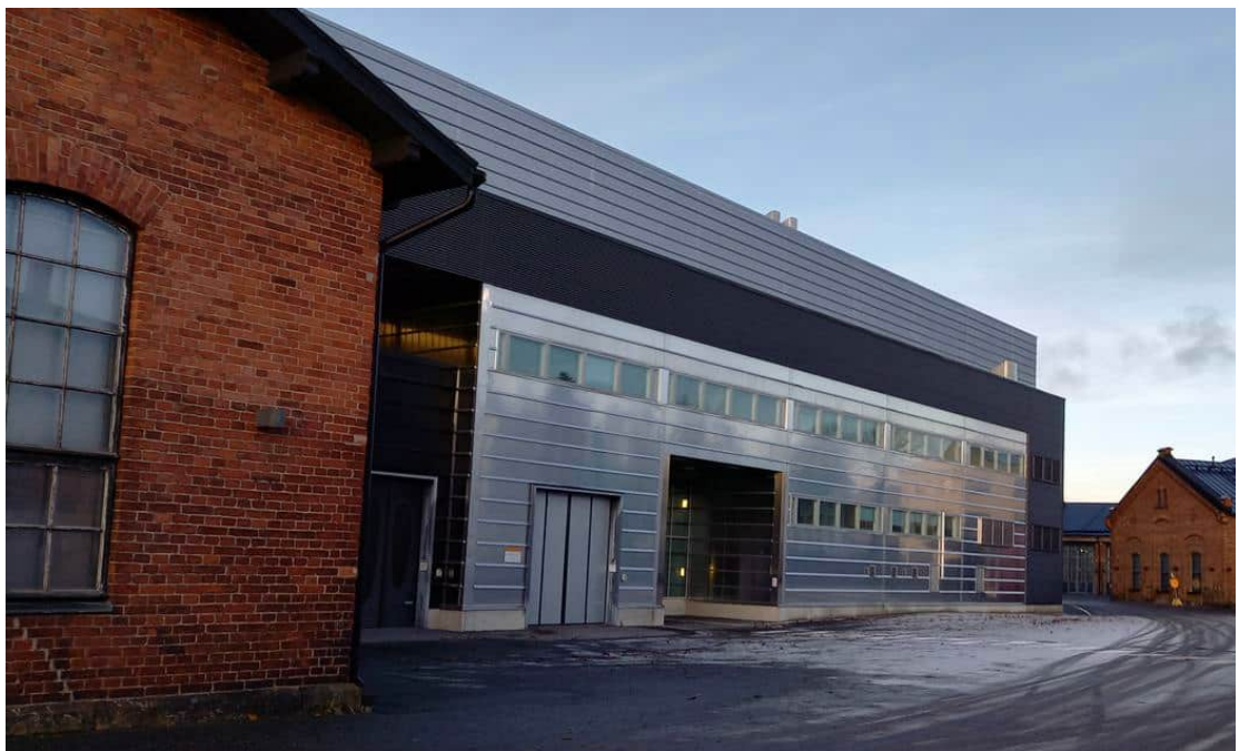
Monteringshallen har byggts ihop med och delvis kring den gamla smedjebyggnaden så att det har varit möjligt att bevara den skyddade byggnaden.
