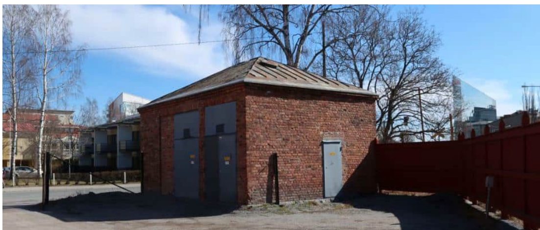
Transformatorbyggnaden fotograferad från Wärtsiläs tomt. Foto: Ramboll.
