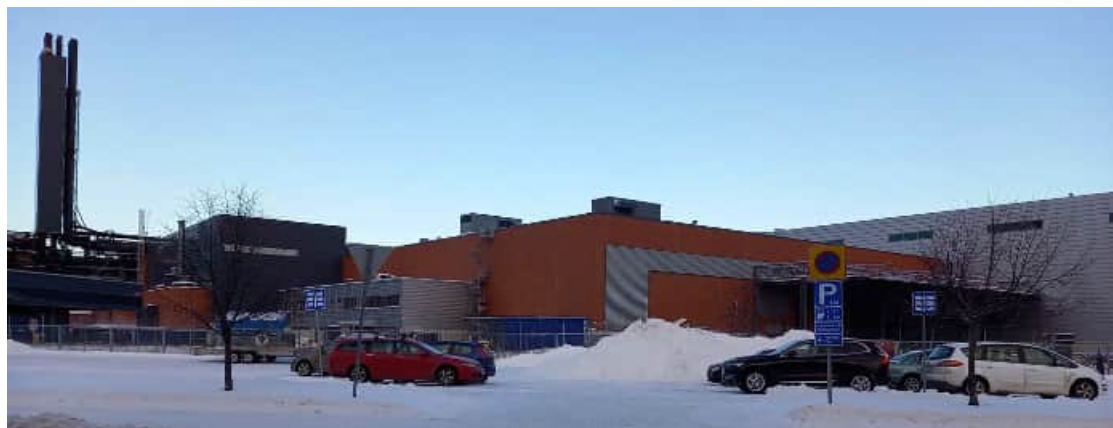
Fabriksbyggnaden fotograferad från Bangatan. Diesel-laboratoriet och överlåtelsecellen till vänster på fotot. Delen i rödtegel i mitten är W20-fabriken. Längst till höger på fotot syns monteringshallen.
