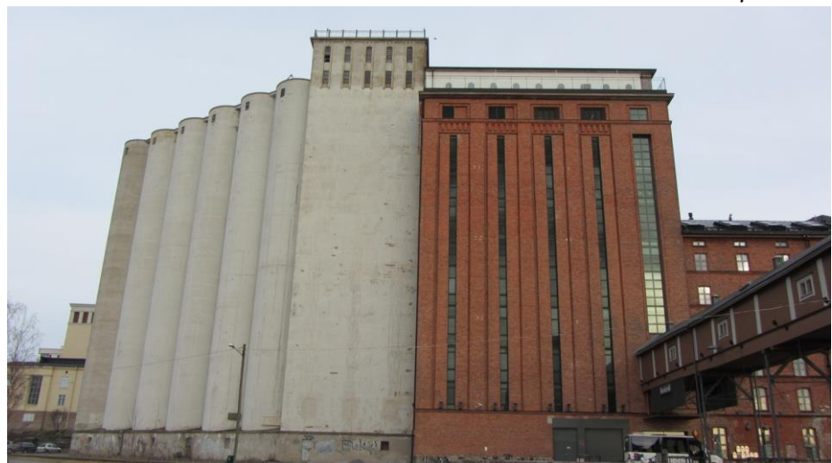
Betonisiilot rannan puolelta.
