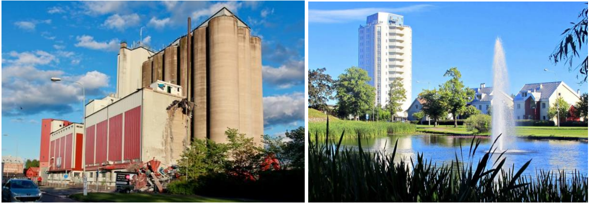
Nyköpingin siilot, purkuvaiheessa ja valmiina.
