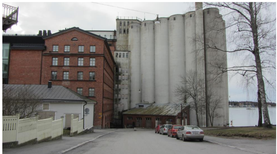
Betongsilorna i ändan av Museigatan
