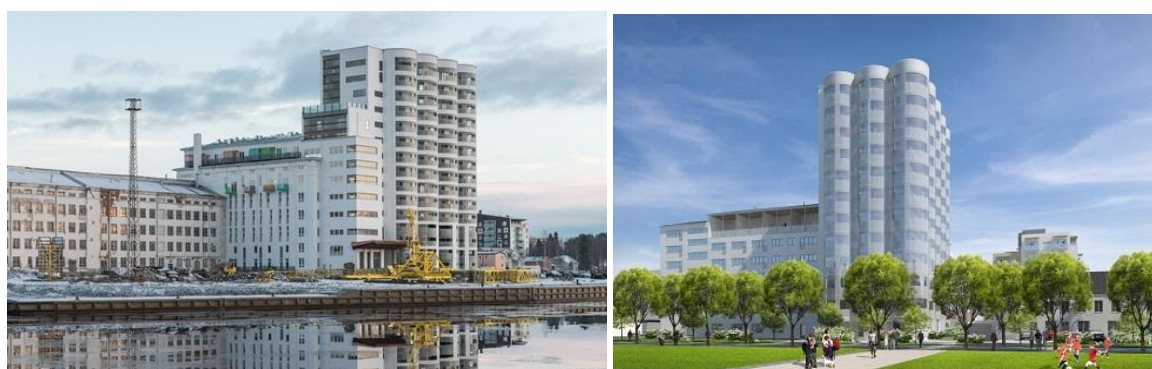
Silorna i Uleåborg
