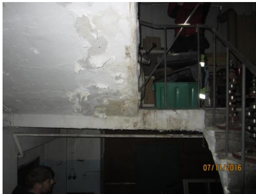
Kuva 13. Torniosan betoniportaavat ovat kastuneet vuosien varrella vesikattovuotojen vuoksi. Betonissa murtumia.
