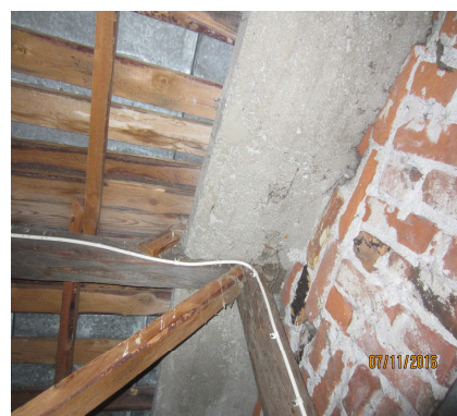
Kuva 8. Uuden osan vesikatosta ja betoniräystästä sisäpuolelta kuvattuna.
