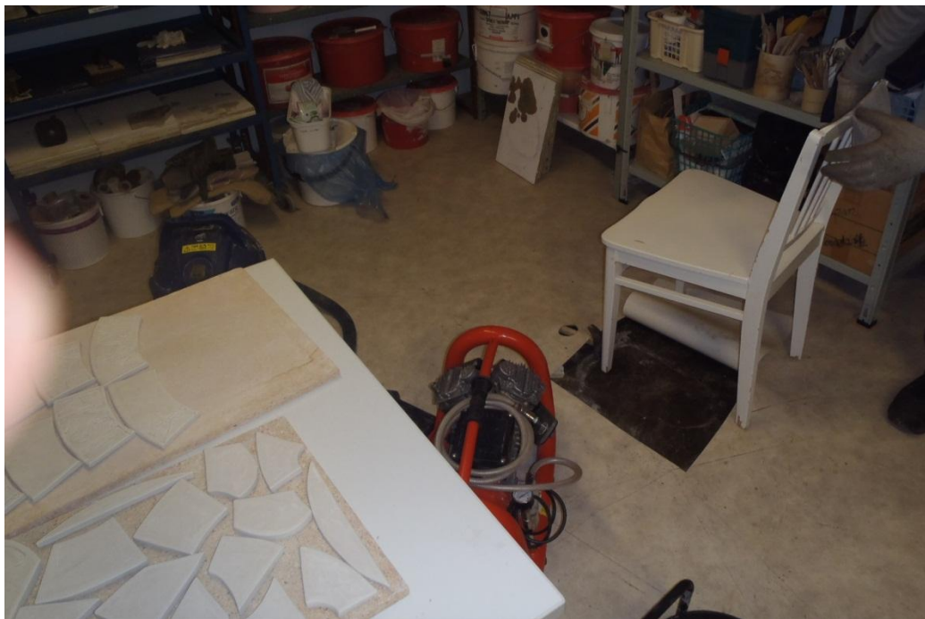
Kuva 38. Näyte PS1. Välipohja. Näyte ~70 mm yläpinnasta (betoni ~70 mm), näyte katkaistu, muovimatto poistettu. Välipohjarakenne näytteenottokohdassa ei selvinnyt porauksen päätyttyä. Näyte sisältää öljyhiilivetyjä C 10 -C 40 1900 mg/kg.
