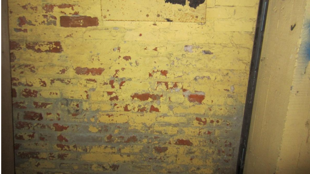
Kuva 11. Mittauspiste MX5. Kannettavalla röntgenfluoresenssispektrometrillä saatujen tulosten perusteella ulkoseinärakenteen pinnassa ei ole merkittävästi kohonneita pitoisuuksia raskasmetalleja. Mittauskorkeus noin 1200 mm lattiatason yläpuolella.
