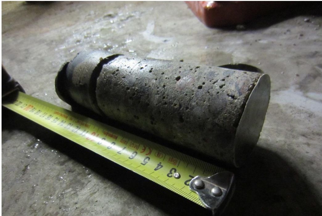
Kuva 17. Näyte PR6. Alapohja. Näyte ~100 mm pinnasta (harmaa maali + betoni ~100 mm), näyte katkaistu. Alapohjarakenne näytteenottokohdassa ei selvinnyt porauksen päätyttyä. Näyte sisältää öljyhiilivetyjä C 10 -C 40 2500 mg/kg.
