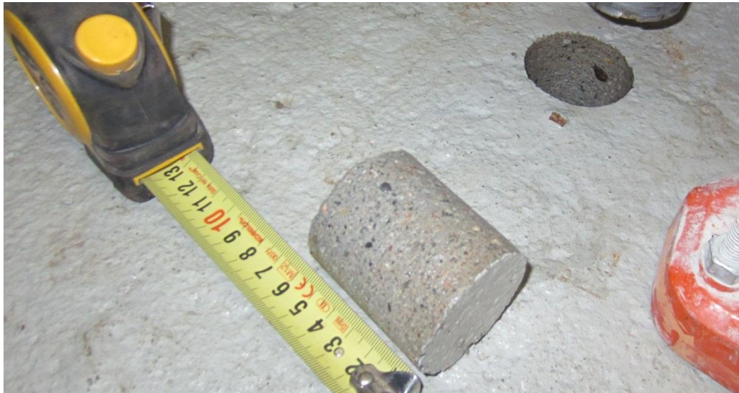
Kuva 25. Näyte PR14. Välipohja. Näyte ~60 mm yläpinnasta (harmaa maali + betoni ~60 mm), näyte katkaistu. Välipohjarakenne näytteenottokohdassa ei selvinnyt porauksen päätyttyä. Näyte sisältää öljyhiilivetyjä C 10 -C 40 1400 mg/kg.
