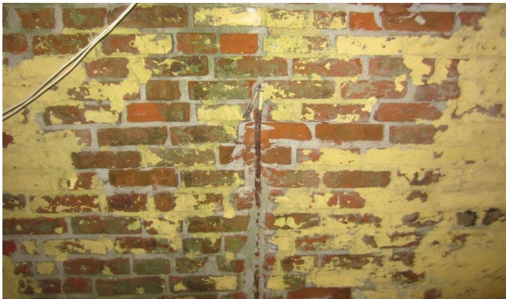
Kuva 10. Mittauspiste MX4. Kannettavalla röntgenfluoresenssispektrometrilla saatujen tulosten perusteella ulkoseinärakenteen pinnassa ei ole merkittävästi kohonneita pitoisuuksia raskasmetalleja. Mittauskorkeus noin 1000 mm lattiatason yläpuolella.
