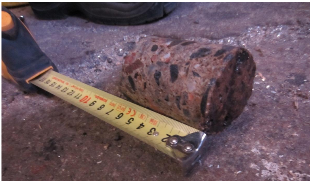
Kuva 22. Näyte PR11. Alapohja. Näyte ~70 mm pinnasta (betoni ~70 mm), näyte katkaistu. Alapohjarakenne näytteenottokohdassa ei selvinnyt porauksen päätyttyä. Näyte sisältää öljyhiilivetyjä C 10 -C 40 1900 mg/kg.
