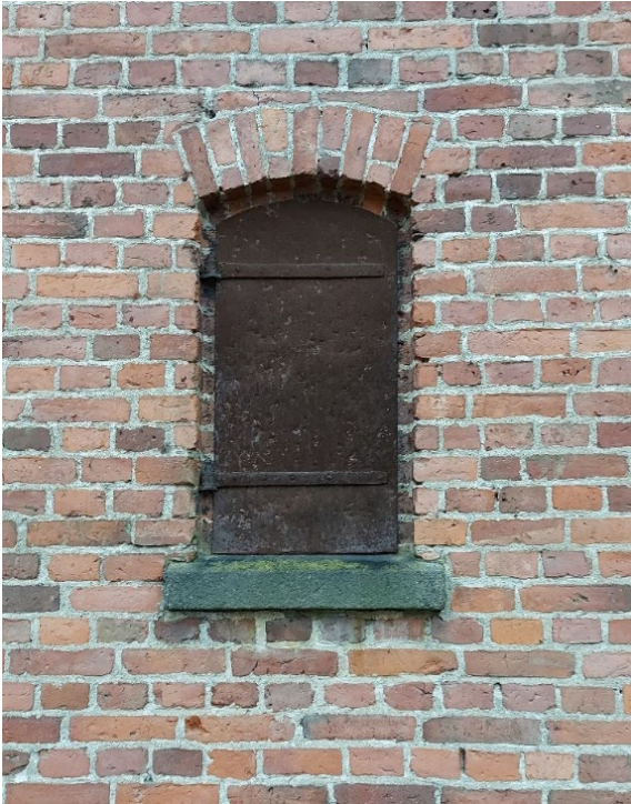
Kuva 64. Pitkillä sivuilla on 18 pientä, rautaluukulla suljettua ikkuna-aukkoa (tuuletusaukkoa).
