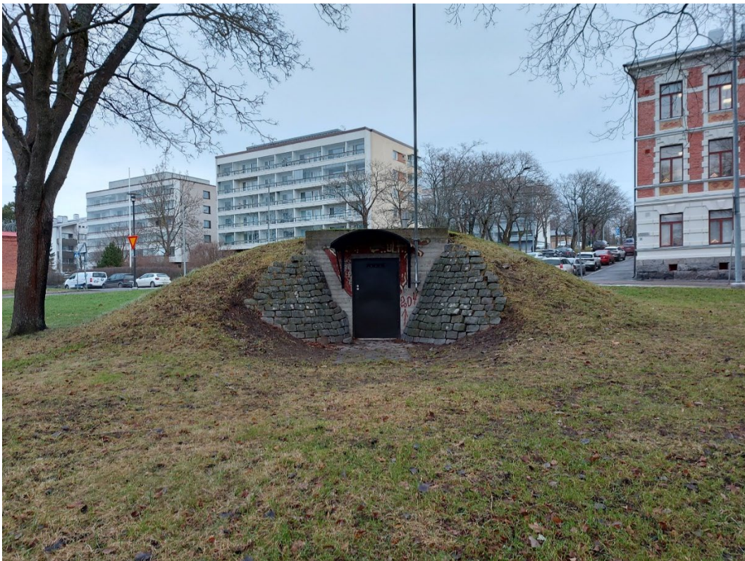
Kuva 97. Puiston koillisnurkassa sijaitseva kellari on Vaasan veden laiterakennus.
