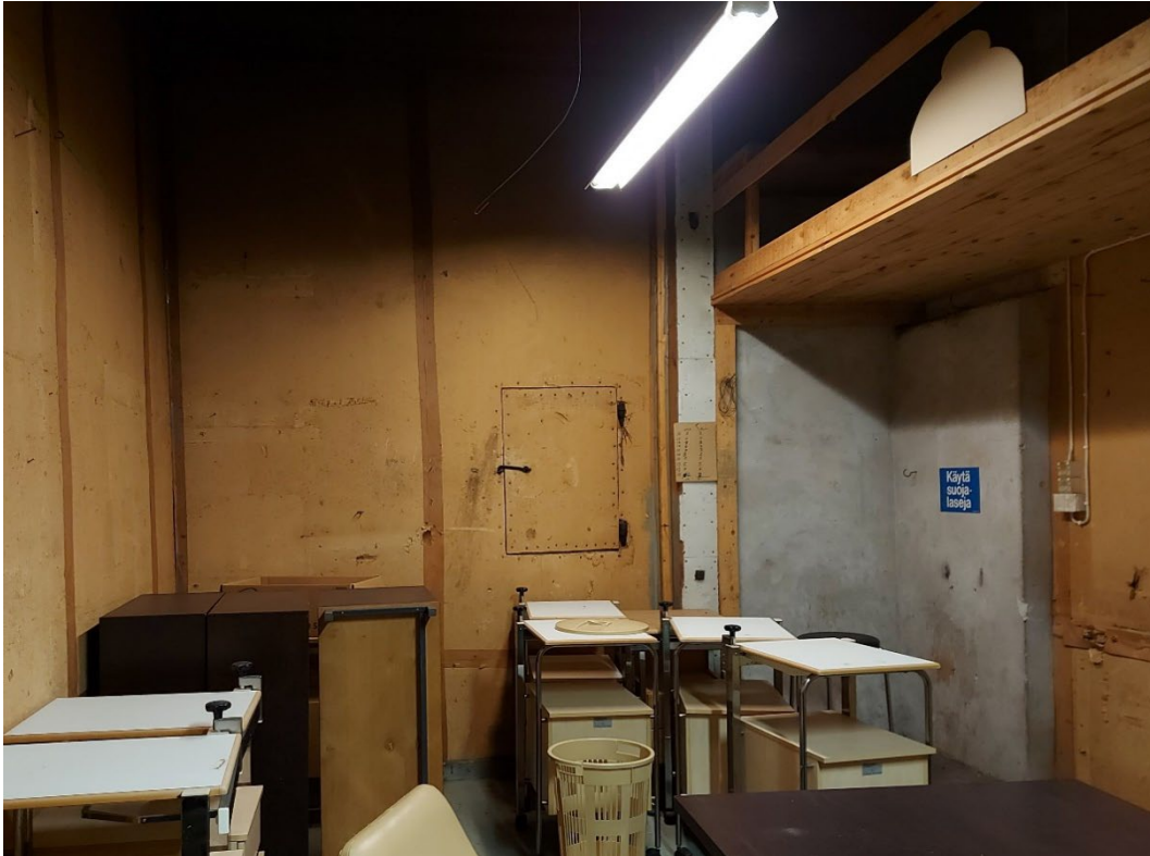
Kuva 72. Luoteiskulmaan on tehty jonkinlainen huoneisto, jossa seiniä on levytetty.
