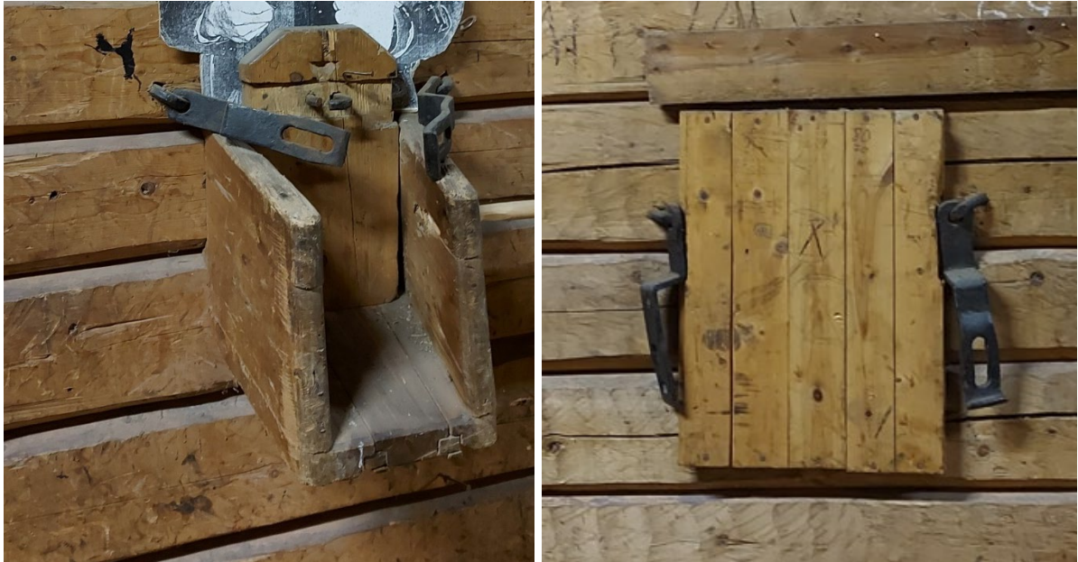
Kuva 22. Vilja on säkitetty käytävään johtavista aukoista, joissa on ollut lukittavat luukut.
