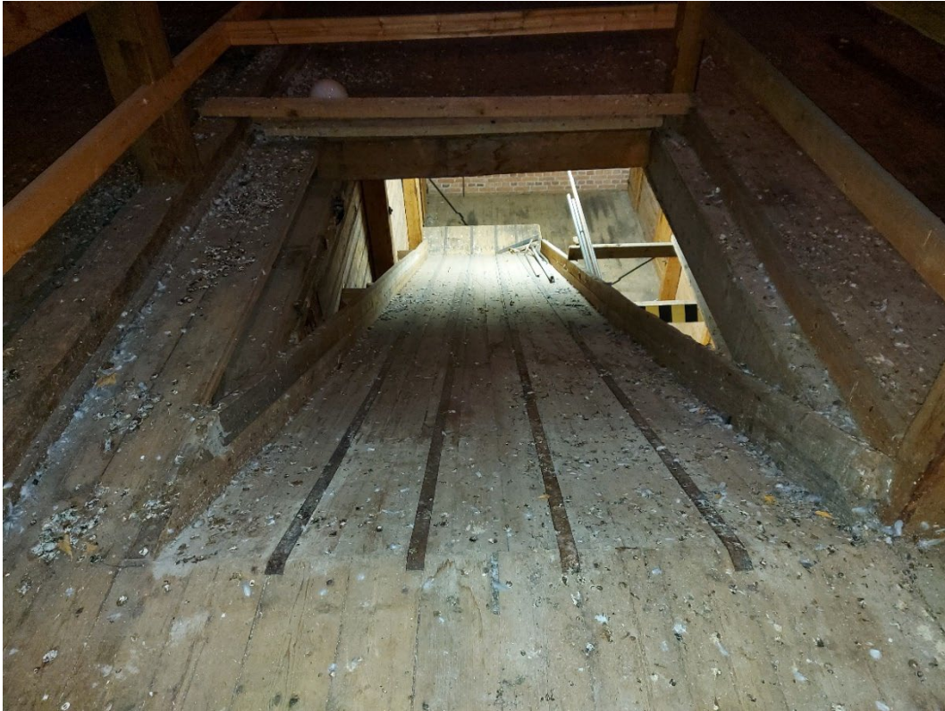
Kuva 83. Ullakolta johtaa luiska toiseen kerrokseen.
