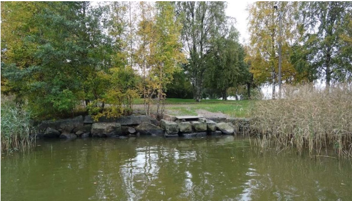
Kuva 46. Räätälinnsaaren pohjoispään laiturinperustus ja rannan harkkokivipengerrystä lounaaseen päin kuvattuna. Kuva ja lähde: Huttunen&Salon 2016, 18.
