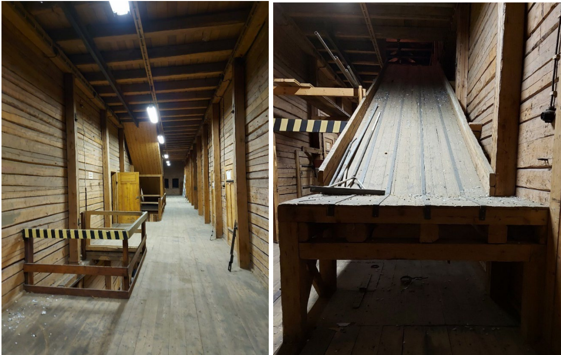
Kuva 78. Toisen kerroksen käytävällä on aukko, jonka kautta voidaan nostaa tavaroita ylös. Katosissa on kisko nostolaitetta varten. Alaspäin tavaraa saadaan myös luiskan kautta.
