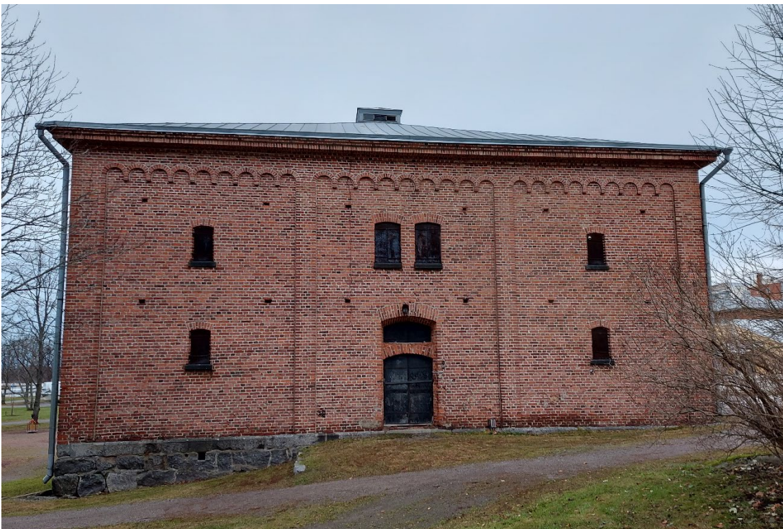
Kuva 60. Eteläpäädyssä näkyy suuri ero kivijalan korkeudessa.
