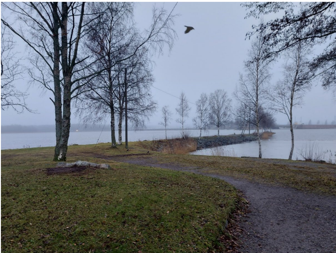
Kuva 91. Aallonmurtaja Räätelinsaaren pohjoispäässä.
