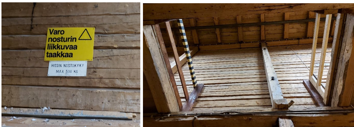
Kuva 26. Nosturia varten tehty aukko välipohjissa on tehty todennäköisesti vasta Puolustusvoimien aikana.
