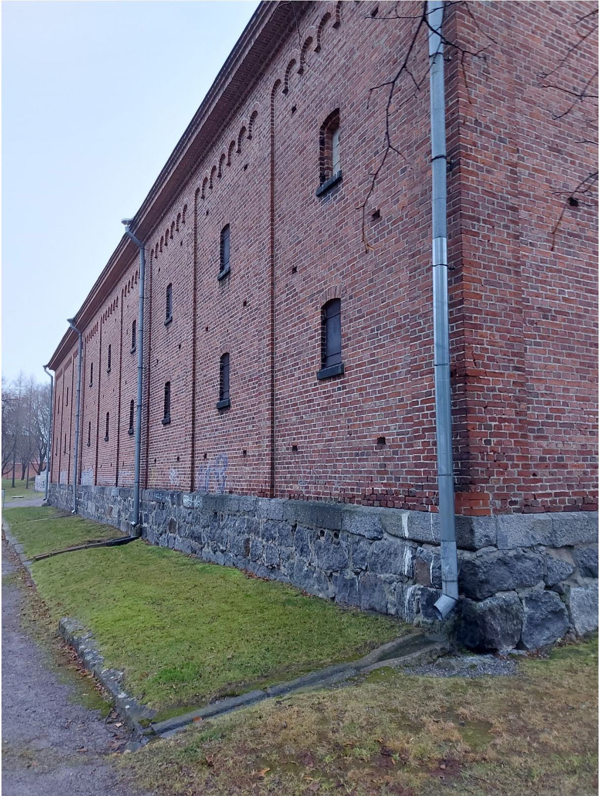
Kuva 61. Länsiseinä sadevedenpoistojärjestelmineen.
