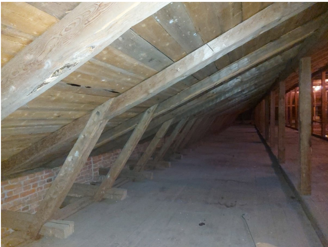
Kuva 84. Kattotuolirakenteena on k p l - ja konttilliitos.
