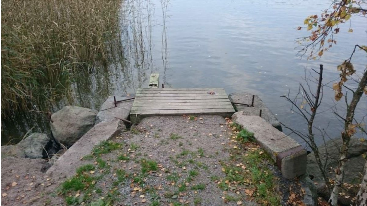
Kuva 45. Räätälinnsaaren pohjoispään laiturinperustus rannalta pohjoisen suuntaan kuvattuna. Kuva ja lähde: Huttunen&Salon 2016, 19.
