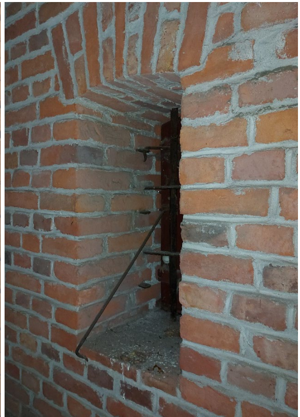
Kuva 80. Hirsikehikon luukut eivät ole samalla kohdalla kuin tiilirungon tuuletusaukot.
