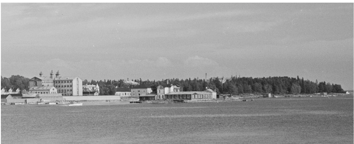
Kuva 43. Osasuurennos edellisestä. Vasemmalla näkyy vankila ja etualalla Räättälinsaari. Makasiinin pohjoispääty näkyy taustalla.
