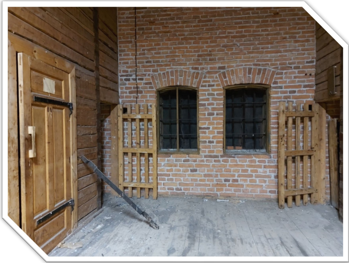
Kuva 76. Tiili- ja hirsirungon väliseen käytävään johtavat portit. Tuuletusaukoissa on kalterit.
