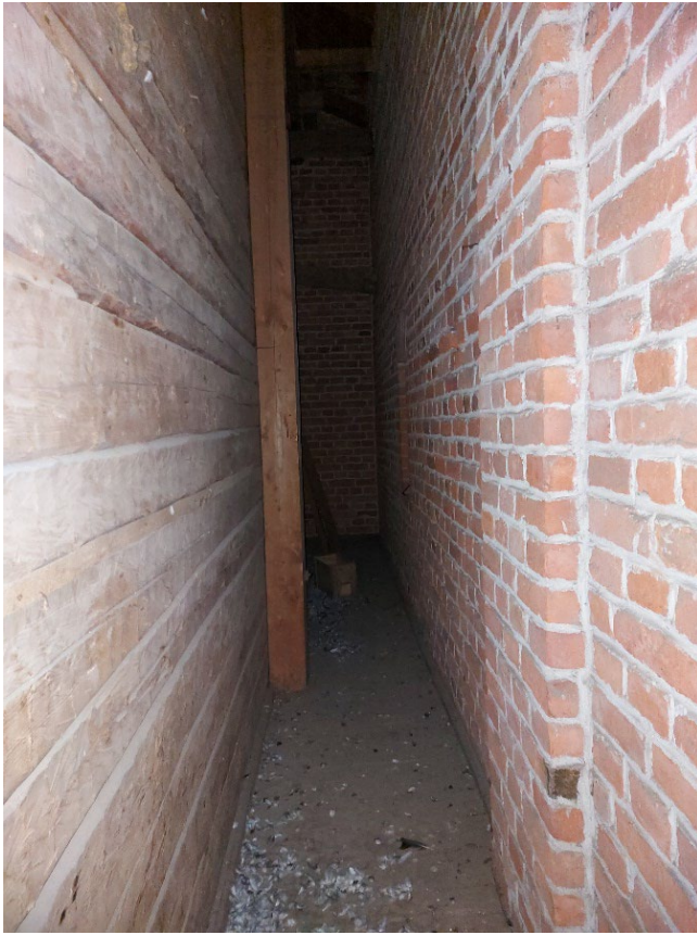
Kuva 77. Tiiliseinän ja hirsirungon välinen tyhjä tila.
