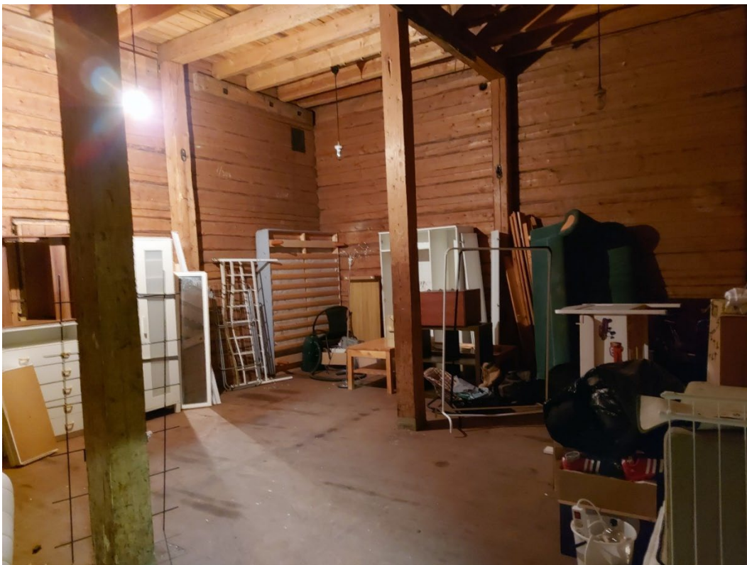
Kuva 71. Huonetilat ovat toimineet aiemmin viljalaareina, joiden väliseinät on tuettu pystytolppiin.
