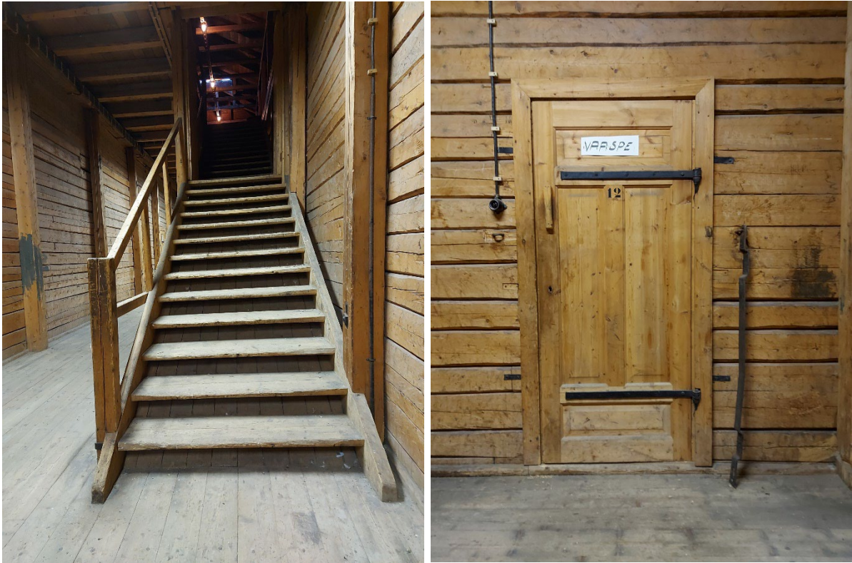
Kuva 81. Portaat toisesta kerroksesta ullakolle. Ovissa on lukon lisäksi rautasalpa lukitusta varten.
